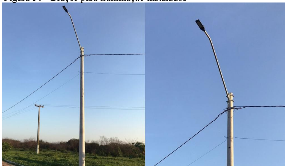
Figura 30 - Braços para iluminação instalados
