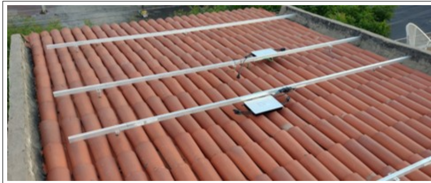
Figura 24 – Microinversor instalado.
