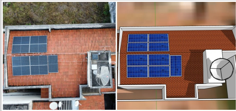
Figura 61 – Sistema com inversor à esquerda instalado e sistema simulado à direita.
