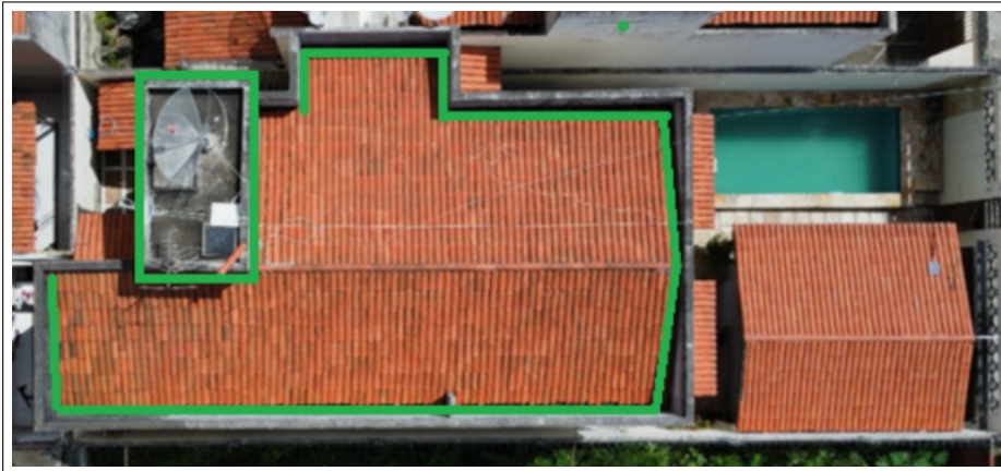
Figura 34 – Vista aérea (Inversor).
