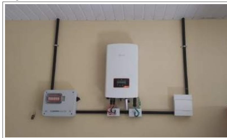
Figura 60 – Sistema com Inversor.
