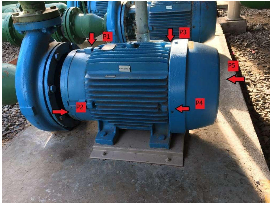
Figura 35 - Conjunto motor bomba em estudo e seus pontos de medição
