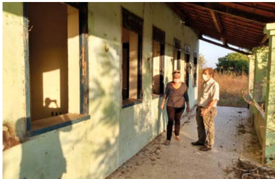
Figura 12 – Interior da Casa do Agrônomo
