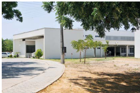
Figura 6 – Vista lateral do prédio principal do Campus de Russas
