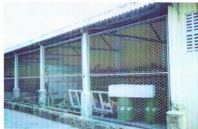
6 Vista da área de carga/ desc.
