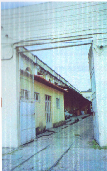
1 Vista da área de carga/desc.
