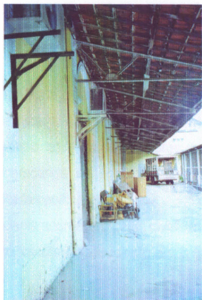
2 Vista da área de carga/desc.
