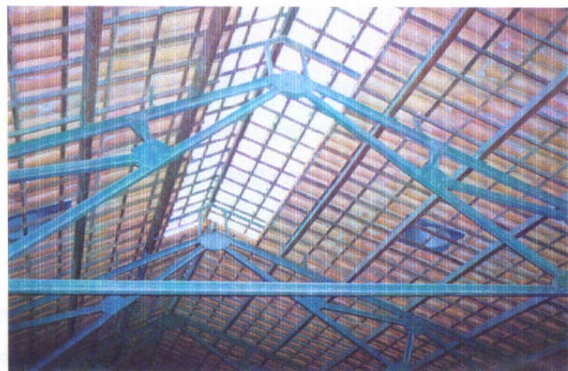
4 Detalhe das tesouras metálicas
