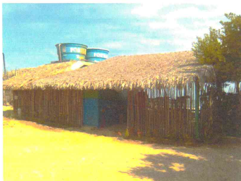
Figura 9. Vista perpendicular da entrada da barraca onde se localiza a sede da APAFG.
