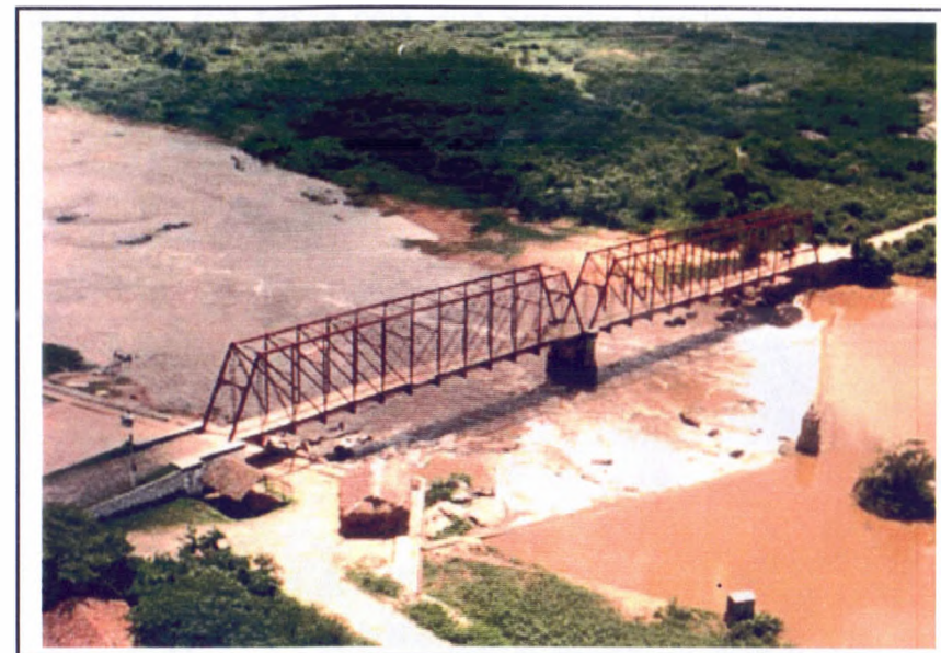
Foto 6.2. C: Vista aérea da Ponte Metálica.
