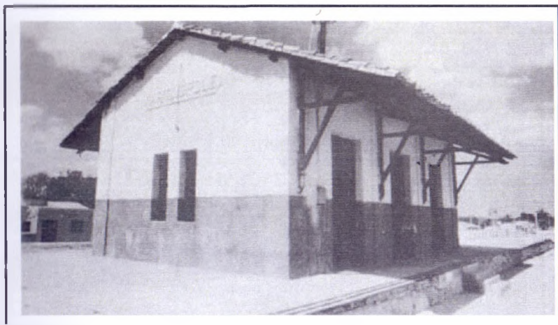
Foto 3.5.2: Estação Ferroviária de Martinópolis, inaugurada em 1930. Na edificação, funciona, hoje, a Biblioteca Municipal.
