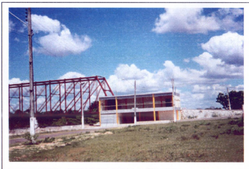
Foto 6.2. B: Construção erguida ao lado da Ponte.
