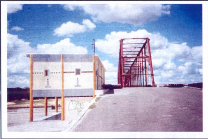
Foto 5.5.2. A: Ponte Metálica e o Palco construído para manifestações públicas.
