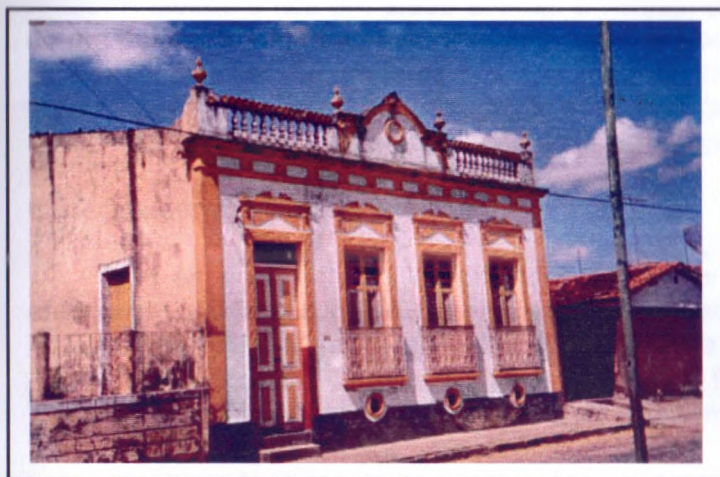
Foto 5.4.C: Residência à rua Vereador Inácio Barcelos.
