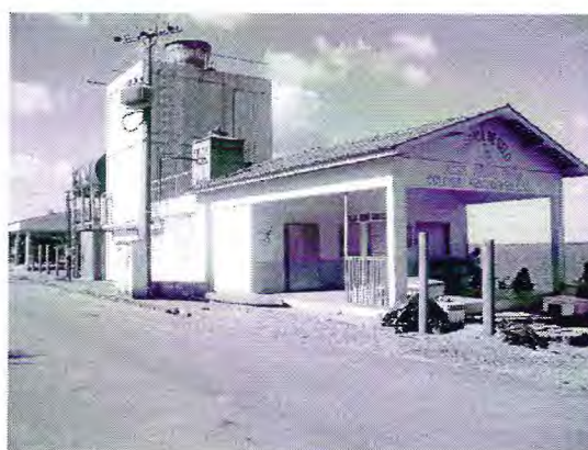
Figura 8. Vista da fábrica de gelo da Colônia de Pescadores Z-53, município de Breu Branco.
