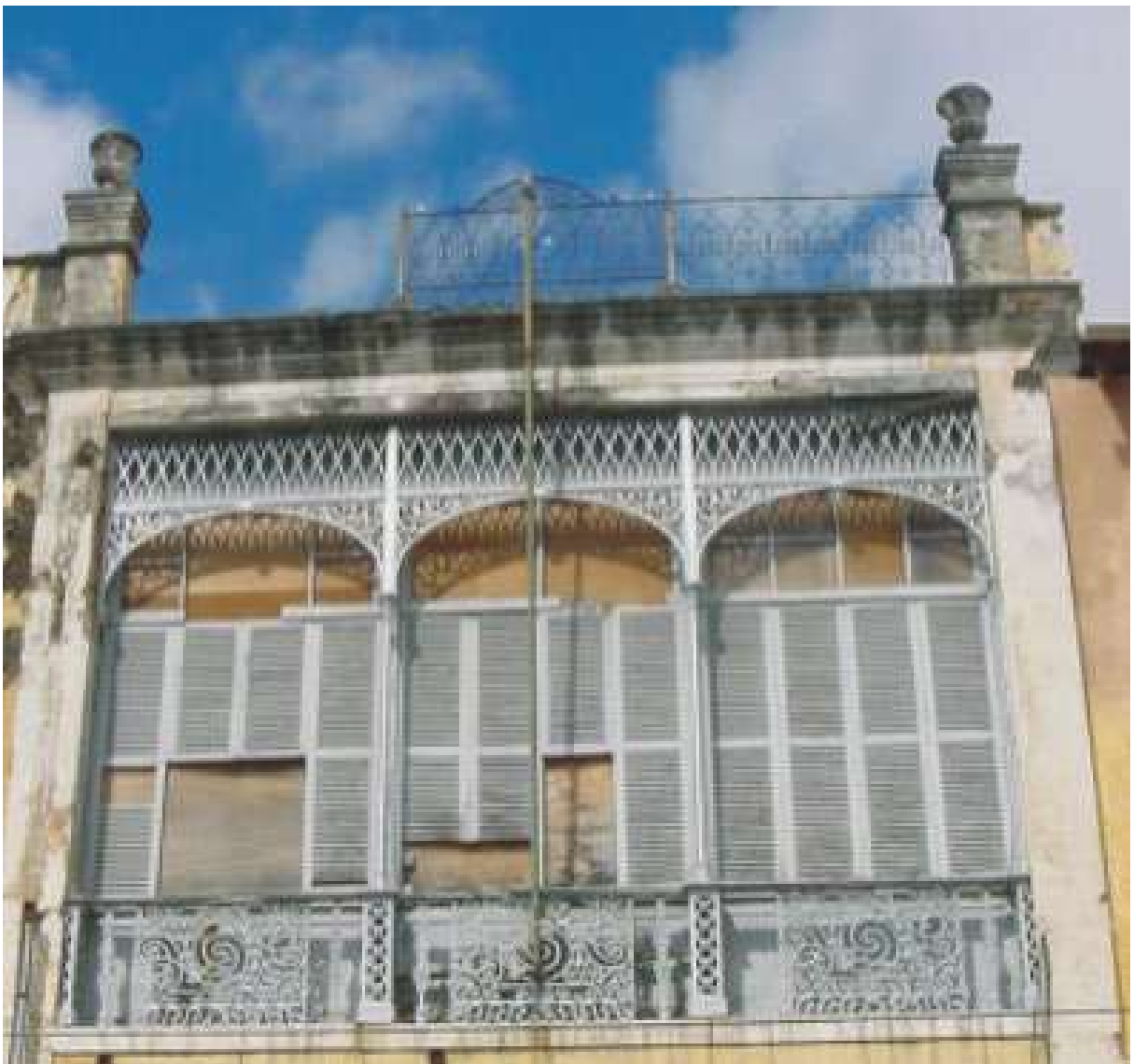
Figura 172.a. Fotografia tirada um pouco antes do restauro em 2005. Parte superior do corpo central da fachada principal em estado de deterioração. Fonte: Acervo pessoal do arquiteto Domingos Linheiro.
