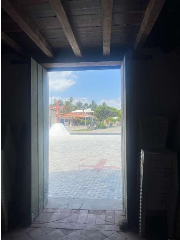
Figura 109. Piso e porta da Igreja de Almofala após o restauro. Vista para o cruzeiro na praça. FONTE: acervo pessoal de Lu Palhano, 2023.
