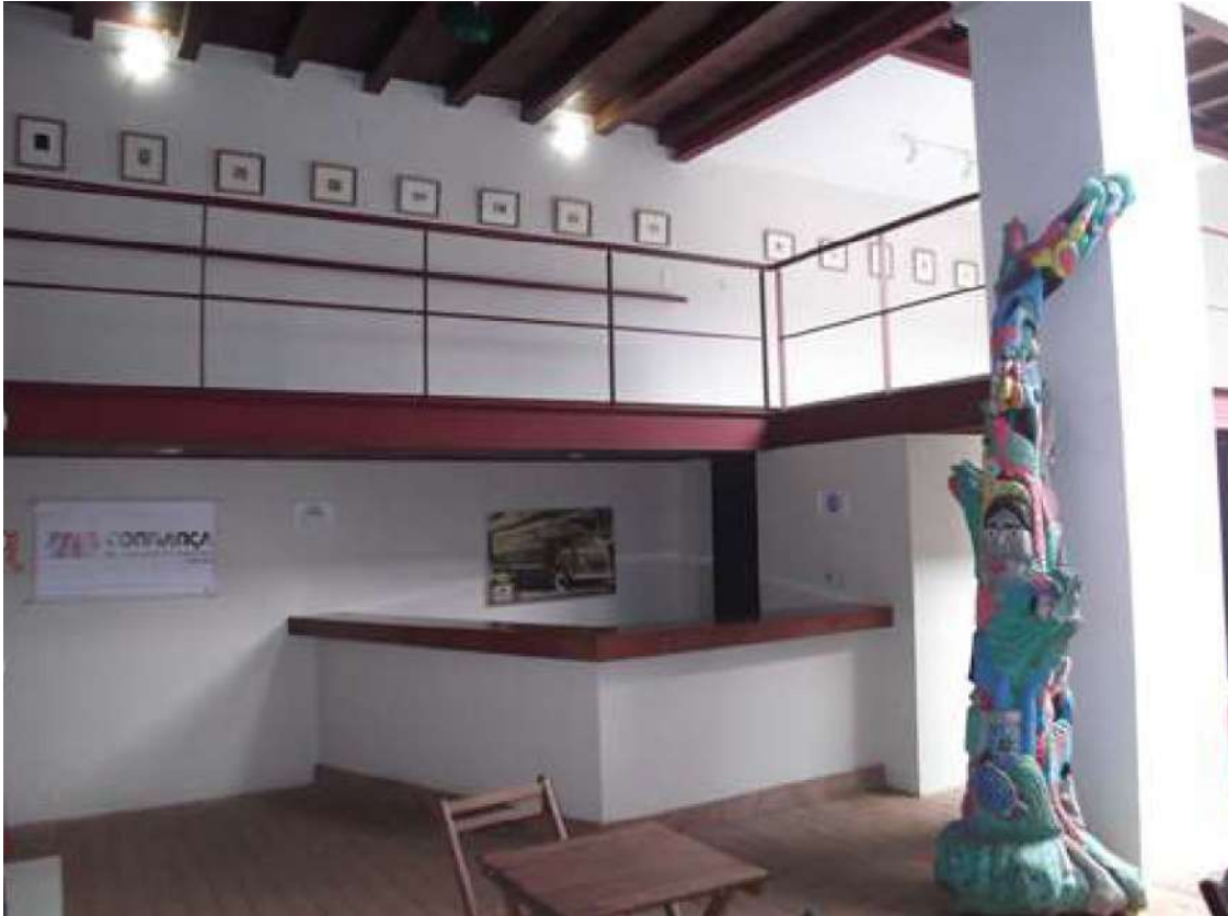
Figura 152. O mezanino e o bar no térreo. Dividindo o pé-direito, a passarela de estrutura metálica atravessa o térreo e conecta o bloco de apoio com o bloco principal. Fonte: acervo do arquiteto Domingos Linheiro.
