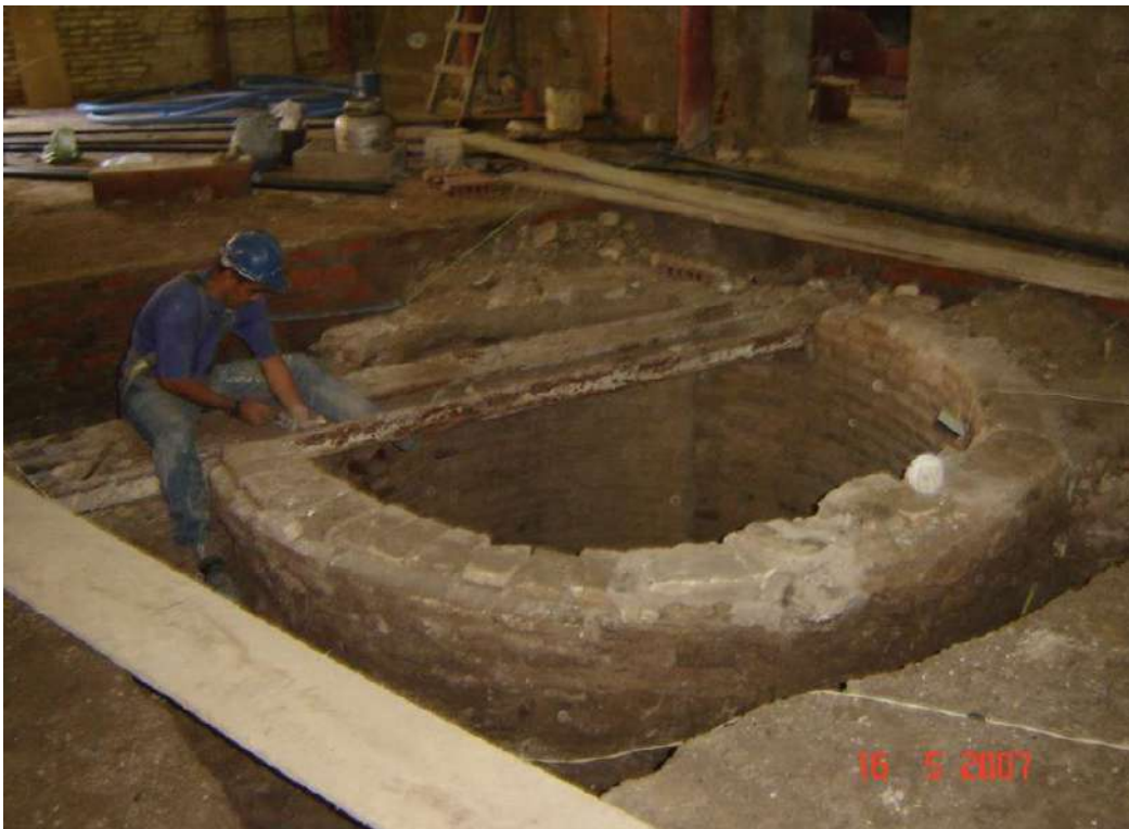
Figura 188. Cacimba encontrada sem a camada de concreto na superfície. FONTE: acervo pessoal do arquiteto Domingos Linheiro.
