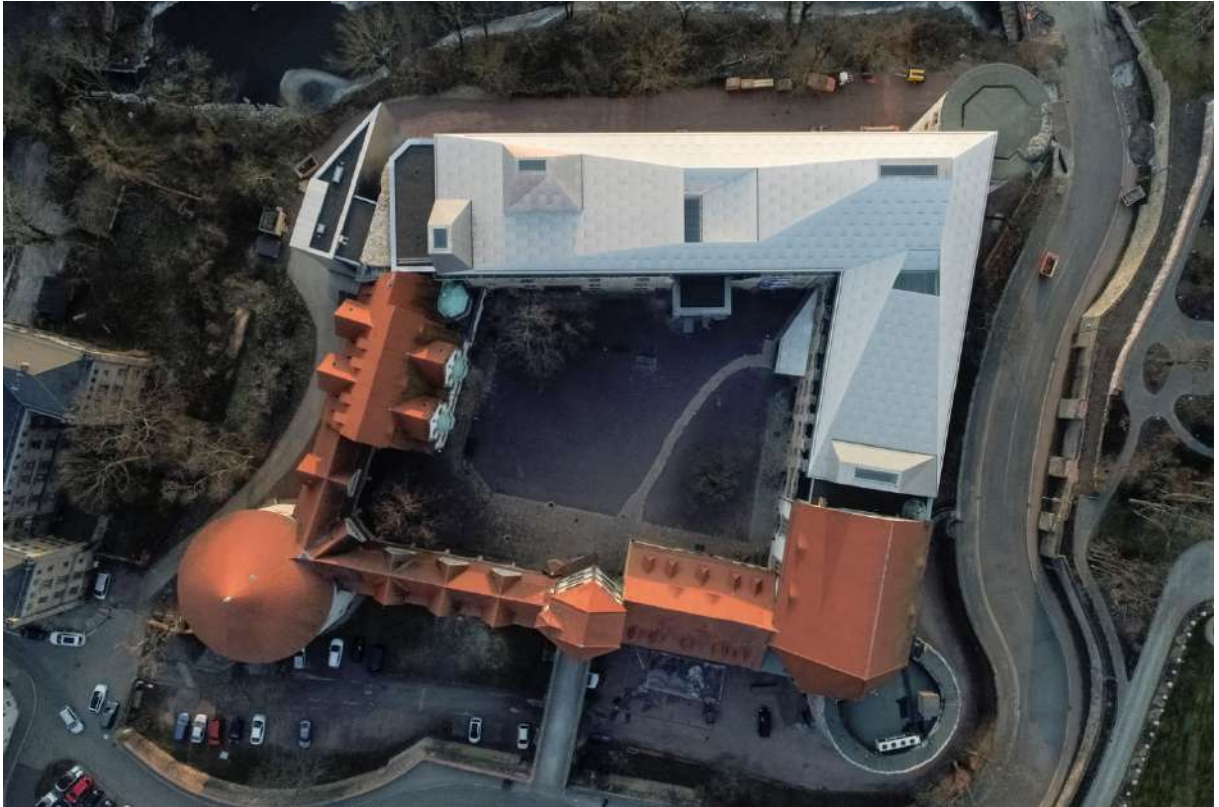
Figura 2. Coberta em destaque do Museu de Moritzburg (Halle, Alemanha). Fonte: https://www.archdaily.com.br/br/913469/uma-nova-cobertura-transformou-este-antigo-castelo-alemao-em-um-grande-espaco-de-exposicoes . Acesso em 1 de março de 2023.
