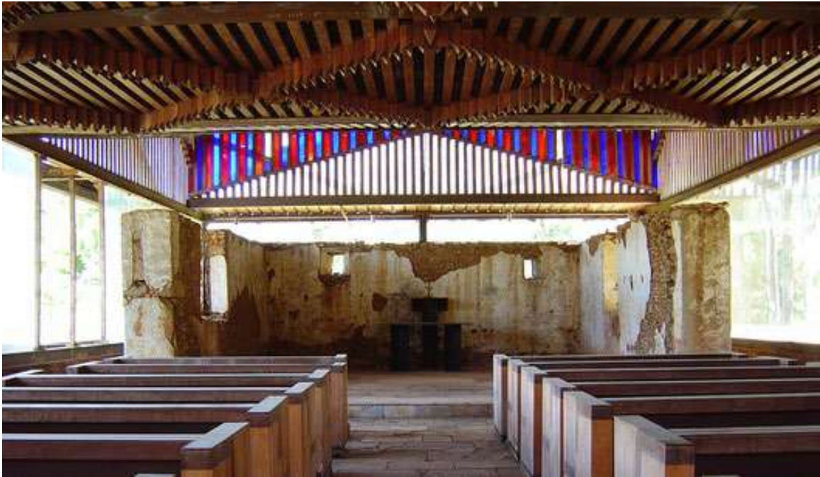
Figura 62. Interior da Capela de Santana. No fundo, o altar cercado pela ruína de pedras. Na parte superior, os vitrais coloridos e a passagem da luz. No forro, uma composição com volumes de madeira entre as vigas da estrutura metálica. FONTE: https:// archdaily.com.br/br/61391/ .
