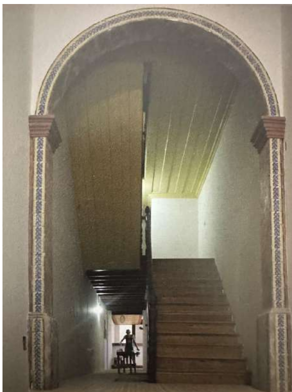
Figura 168. Portal com moldura de azulejos.
