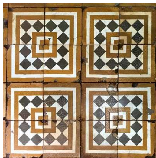
Figura 169. Piso de ladrilho.
