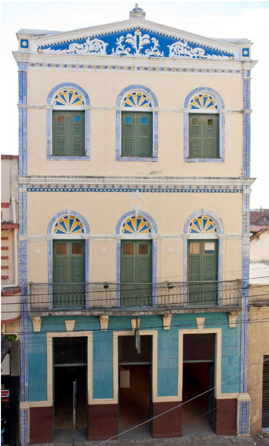
Figura 140. Sobrado José Lourenço depois do restauro. Imagem da fachada principal.
