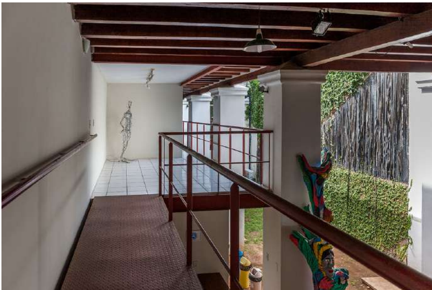
Figura 151. No mezanino, passarela com guarda-corpo em estrutura metálica na cor vermelha e a vista para o jardim do pátio central. No centro, a sequência de pilares robustos e antigos apoiando as novas estruturas. Fonte: Acesso em
