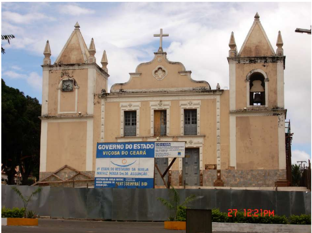
Figura 129. Igreja Matriz de N. Sra. da Assunção, Viçosa do Ceará. Antes do restauro com os tapumes da obra. FONTE: disponível em < https://vicosace.blogspot.com/ > . Acesso em fevereiro de 2023.
