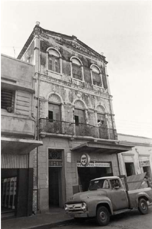
Figura 142. Imagem da fachada principal mostrando a abertura de uma porta larga de garagem, em substituição a outras duas de menor largura.
