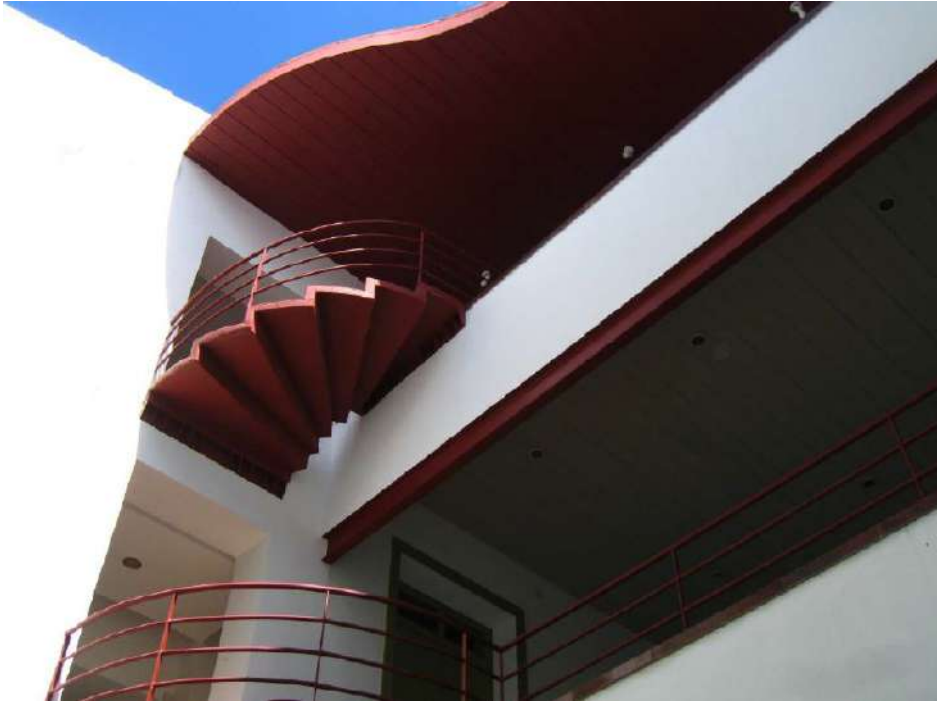
Figura 193. Passagens novas sobre o jardim feitas com estrutura metálica. FONTE: acervo pessoal do arquiteto Domingos Linheiro.
