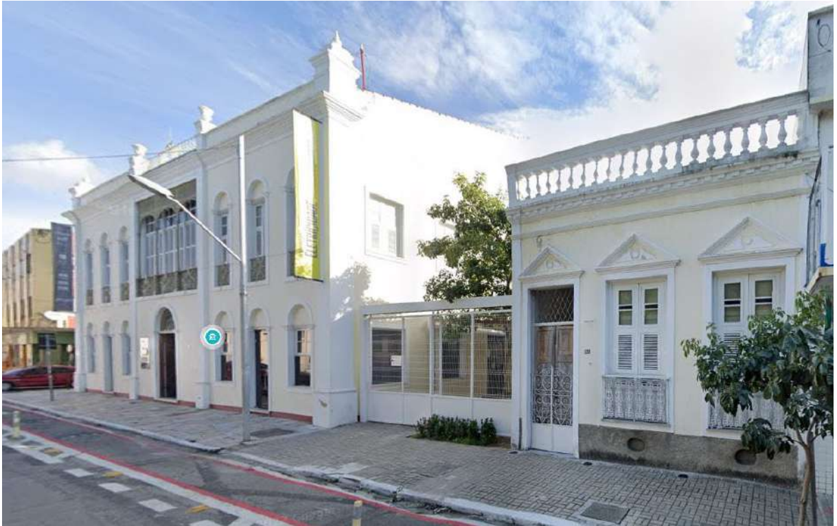
Figura 199. Museu da Indústria. Vista da Rua João Moreira e a casa ao lado, servindo como anexo do museu.
