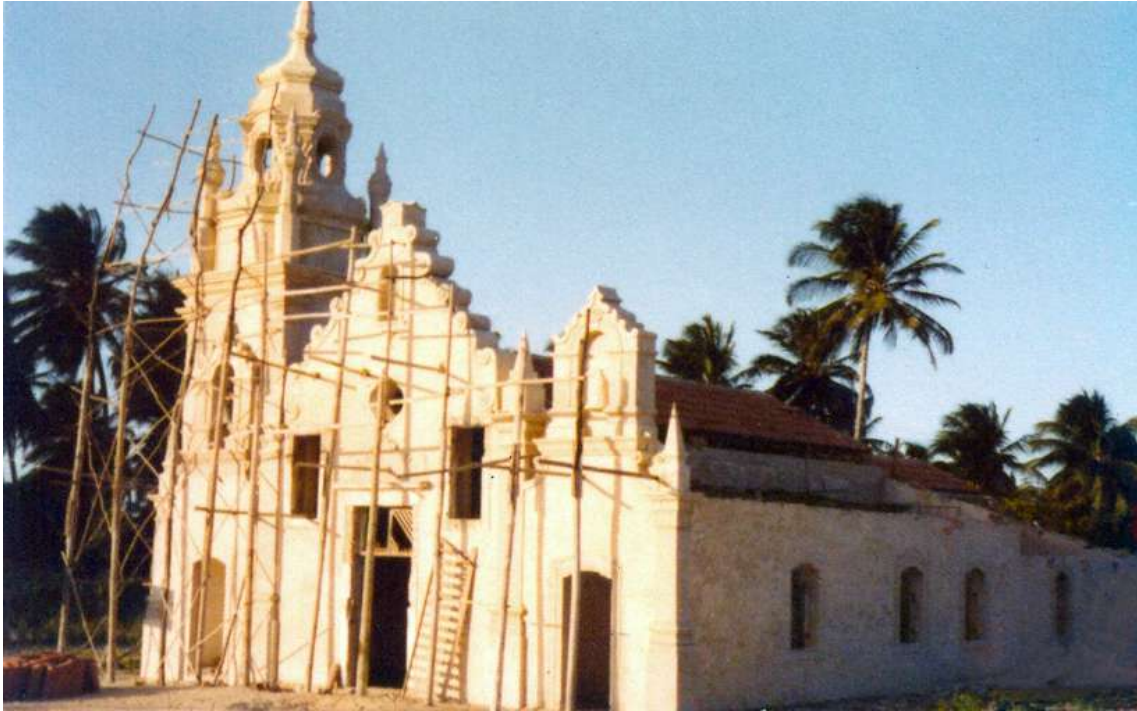
Figura 112. Igreja de Nossa Senhora da Conceição de Almofala ,CE. Durante a obra de restauro, andaimes na fachada em 1983. FONTE: acervo pessoal do arquiteto Domingos Linheiro.
