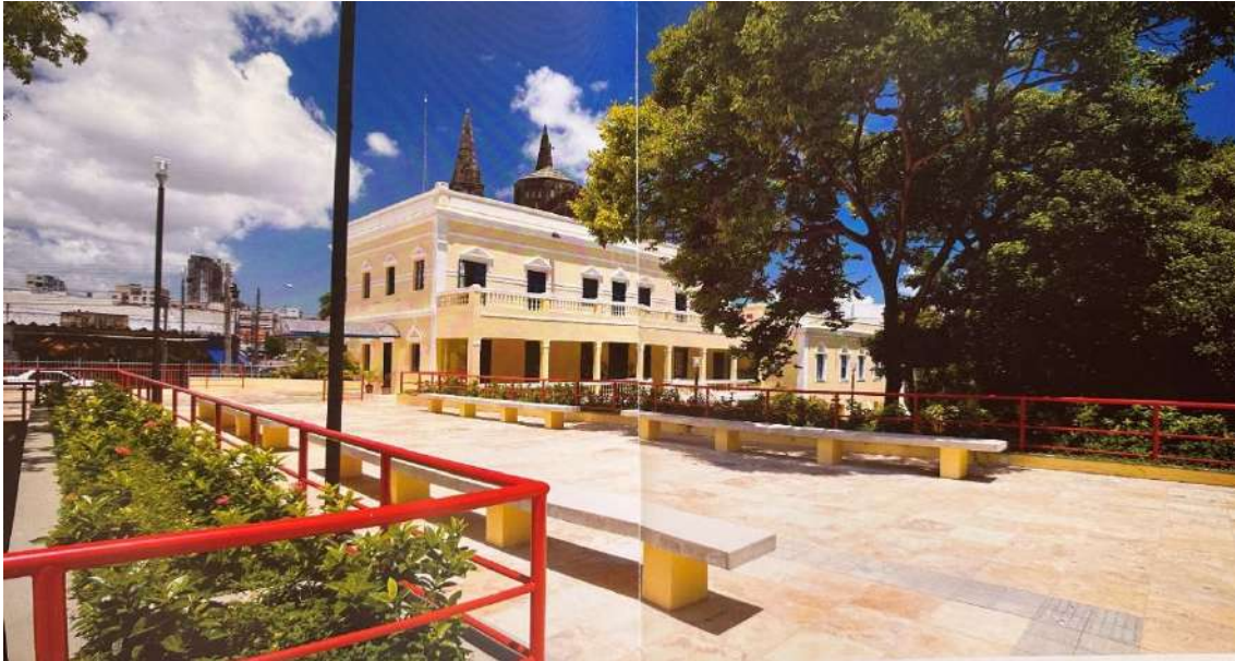
Figura 208. Palácio restaurado e explanada (praça) protegida com guarda-corpo. FONTE: III Prêmio IAB de Arquitetura, 2009.
