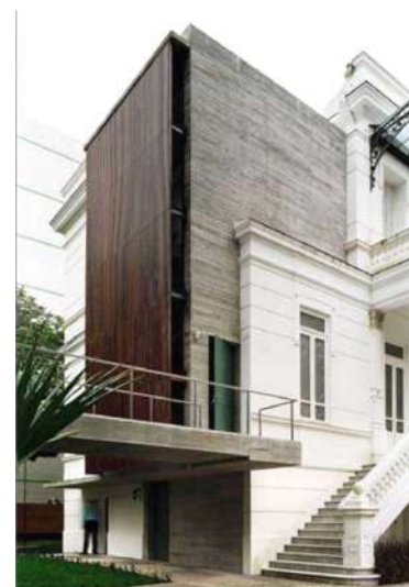
Figura 53, 54 e 55. A nova coluna de circulação vertical para abrigo do elevador e da escada e acesso de todos os níveis. Demolição, construção e conexão do novo com o antigo. Fonte: Acervo do Escritório Brasil Arquitetura (NAHAS, 2008, p. 291).
