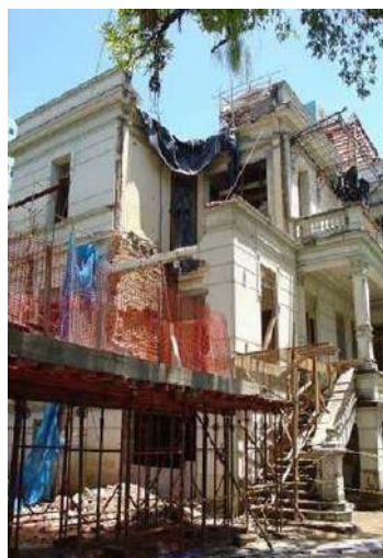
Figura 53, 54 e 55. A nova coluna de circulação vertical para abrigo do elevador e da escada e acesso de todos os níveis. Demolição, construção e conexão do novo com o antigo. Fonte: Acervo do Escritório Brasil Arquitetura (NAHAS, 2008, p. 291).
