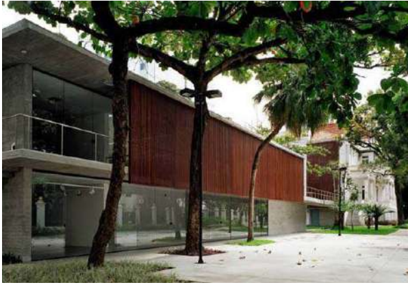
Figuras 57 e 58. À esquerda, o novo bloco e a fachada protegida com ripado de madeira. Embaixo, vista da passarela e sua continuação ladeando a edificação. No térreo, o bar/café integrado ao jardim. Fonte: NAHAS, 2008, p.258.
