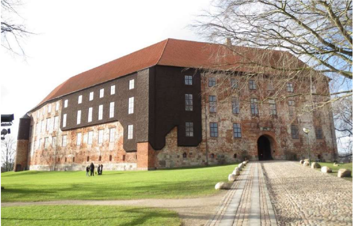
Figura 15. Castelo de Koldinghus na Dinamarca, depois da intervenção de restauro. FONTE: BRENDLE, Betânia, 2017.
