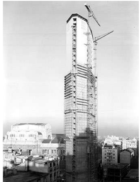
Figuras 25 e 26. Edifício Pirelli, Milão, Itália. À esquerda, corte mostrando os 127m de altura para os 33 andares do edifício e no subsolo, estacionamento e auditório. À direita, imagem durante a construção. https://www.archdaily.com/481062/ad-classics-pirelli-tower-gio-ponti-pier-luigi-nervi . Fonte: Acesso em 5 de março de 2023.
