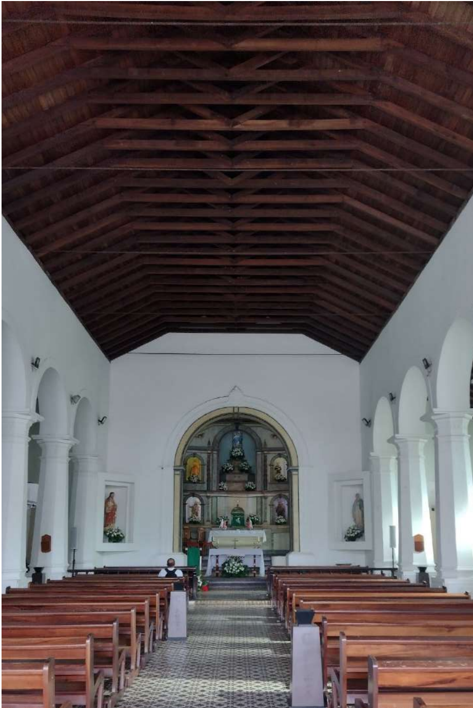
Figura 137. Igreja Matriz de Viçosa. Vista interna com destaque para o altar e a estrutura de madeira aparente do telhado com linhas formando um trapézio. Fonte: acervo pessoal de Beatriz Chaves, 2022.
