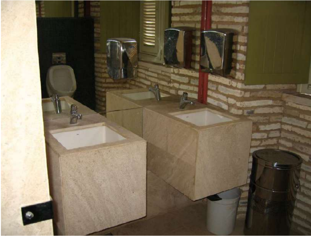
Figura 195. Instalações novas para os banheiros. FONTE: acervo pessoal do arquiteto Domingos Linheiro.
