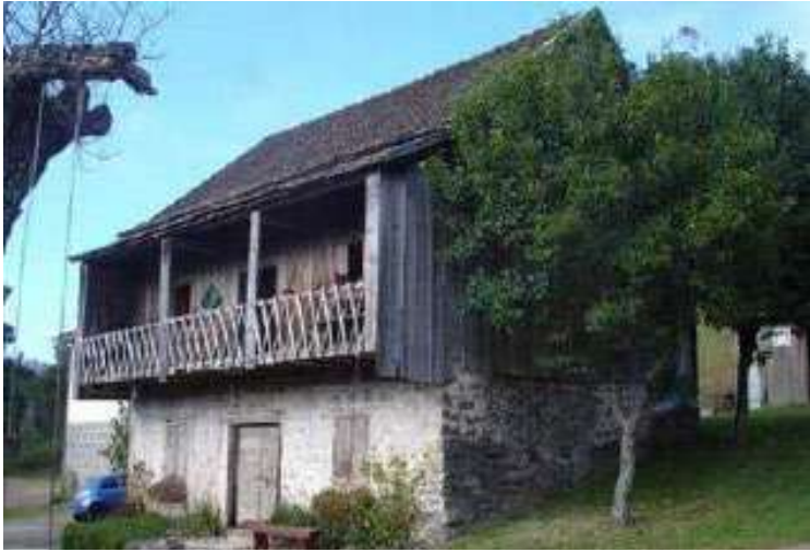
Figura 47. Edificação avarandada da região que serviu como inspiração para a os passadiços da intervenção contemporânea do complexo do museu. Fonte: NAHAS, 2008, p. 347.
