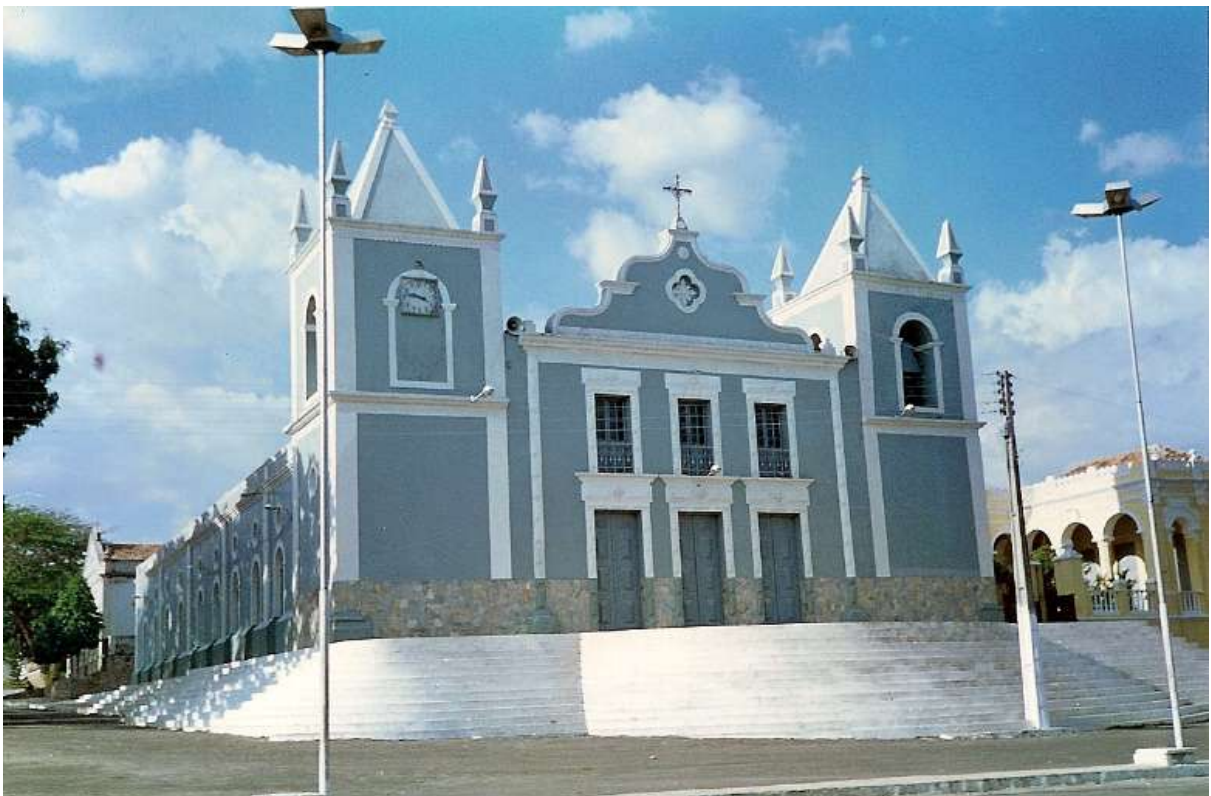
Figura 130. Igreja Matriz de N. Sra. da Assunção, Viçosa do Ceará. Antes do restauro, escadaria envolvendo todas as fachadas da igreja. FONTE: Acervo Domingos Linheiro.
