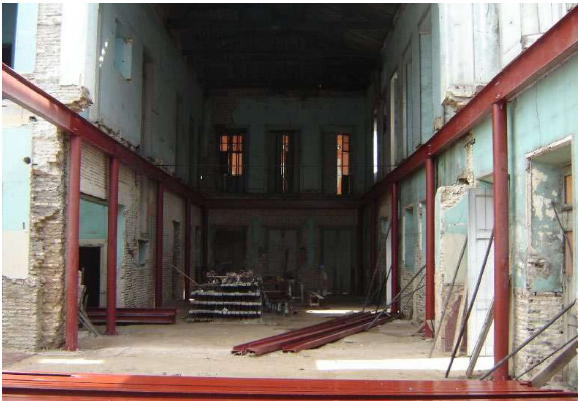
Figuras 177. Durante a obra, vigas e pilares metálicos para sustentação de uma laje treliçada a ser instalada. FONTE: acervo pessoal do arquiteto Domingos Linheiro.
