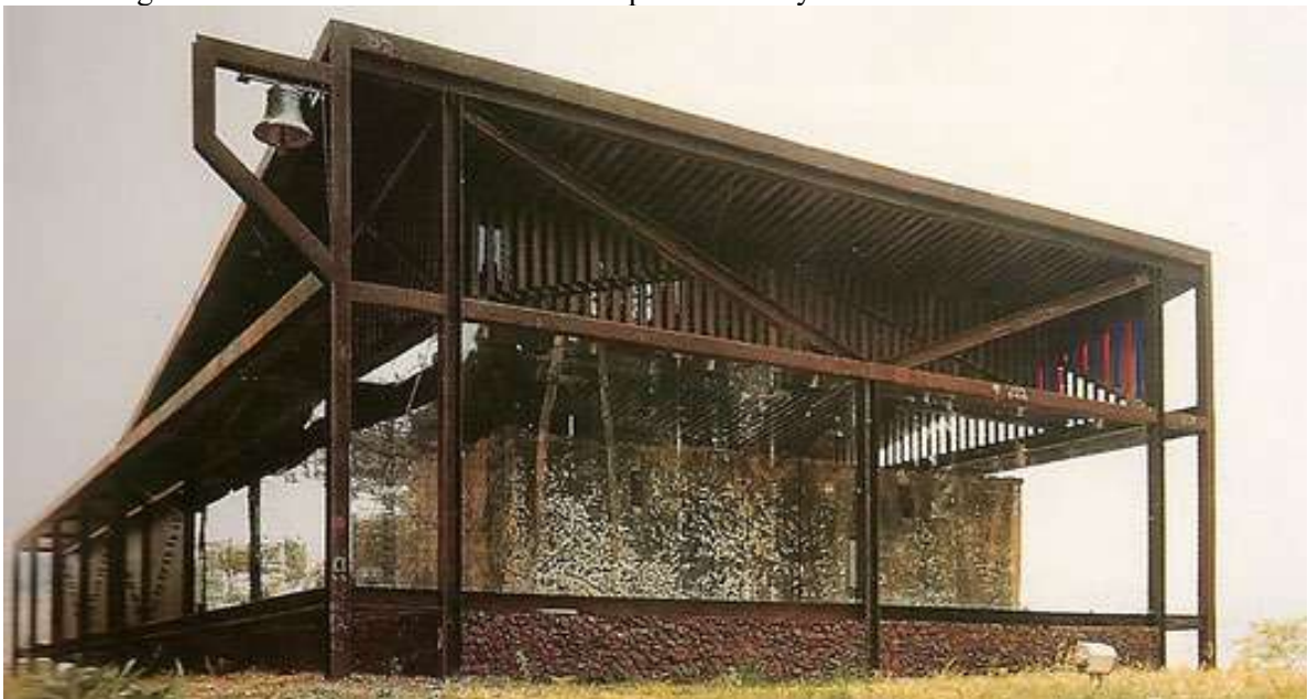
Figura 63. Fachadas da Capela de Santana. Estrutura metálica modulada e evidenciada. Vedações com vidros e ripados de madeira. FONTE: https:// archdaily.com.br/br/61391/
