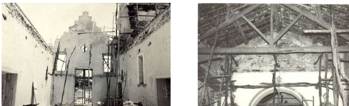
Figura 106. Igreja de Nossa Senhora da Conceição de Almofala, CE. À esquerda, depois da retirada da cobertura e marcas da estrutura do telhado na alvenaria. Fonte: Superintendência do IPHAN -CE.
