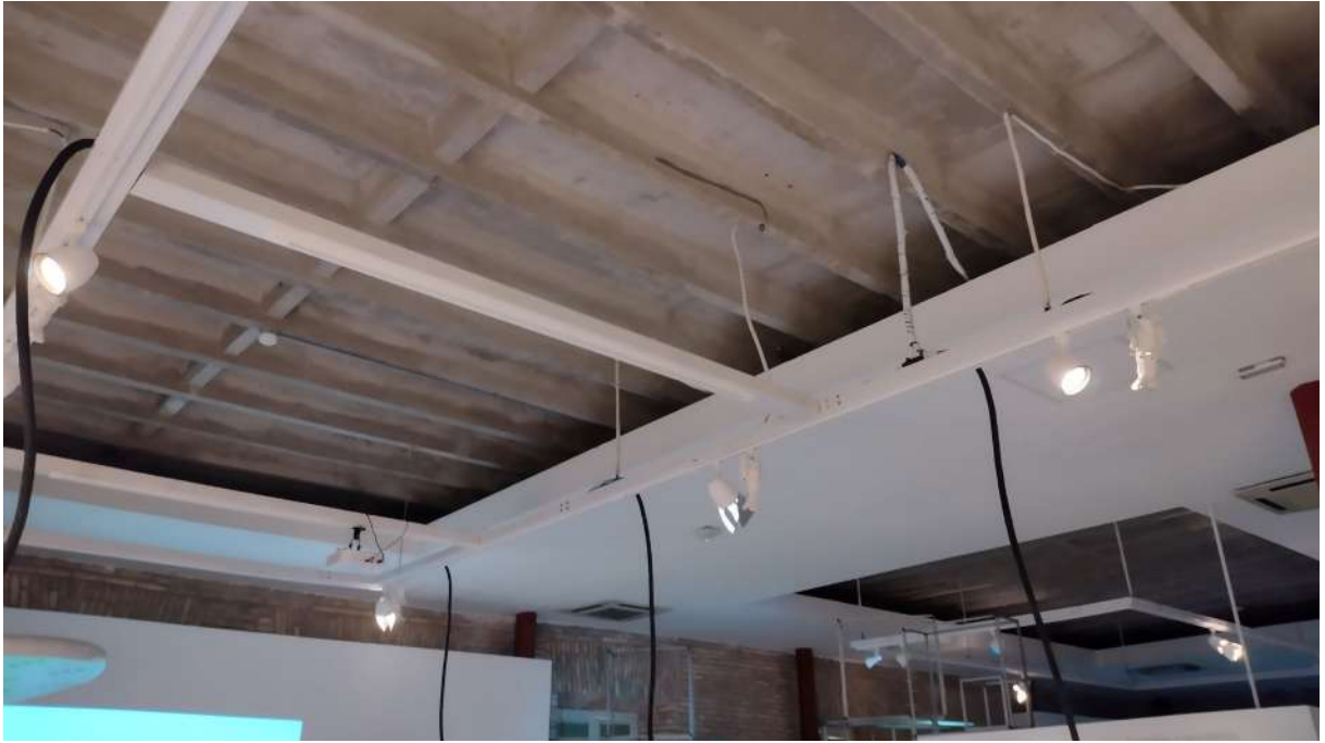
Figura 185. Salão de exposição. Forro de gesso, laje aparente e iluminação direcionável. FONTE: acervo pessoal da autora, 2022.
