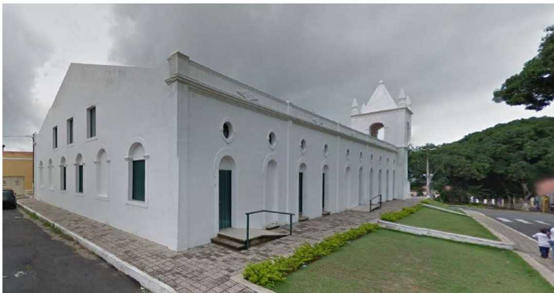
Figura 138. Igreja Matriz de Viçosa. Vista da fachada lateral com as rampas novas e da fachada posterior. Fonte: acervo pessoal de Beatriz Chaves, 2022.
