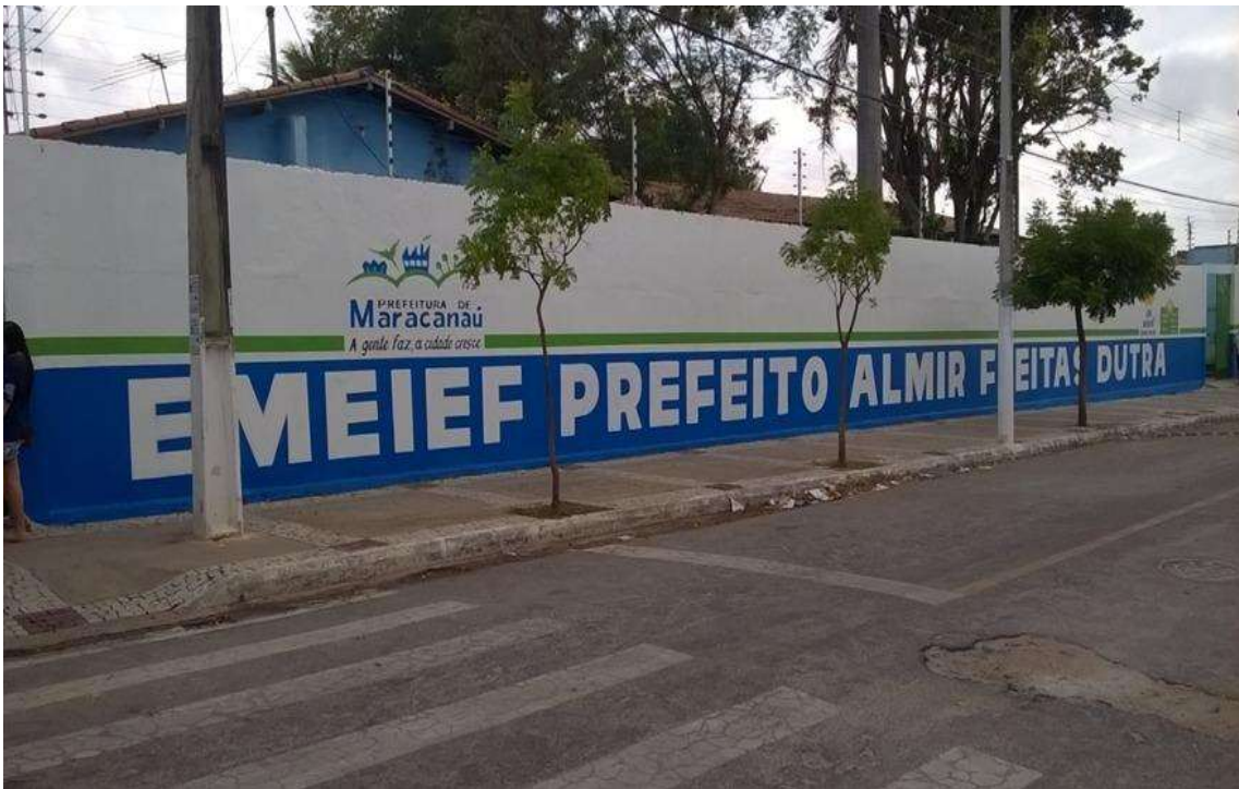
Fotografia 7 – Fachada da Escola
