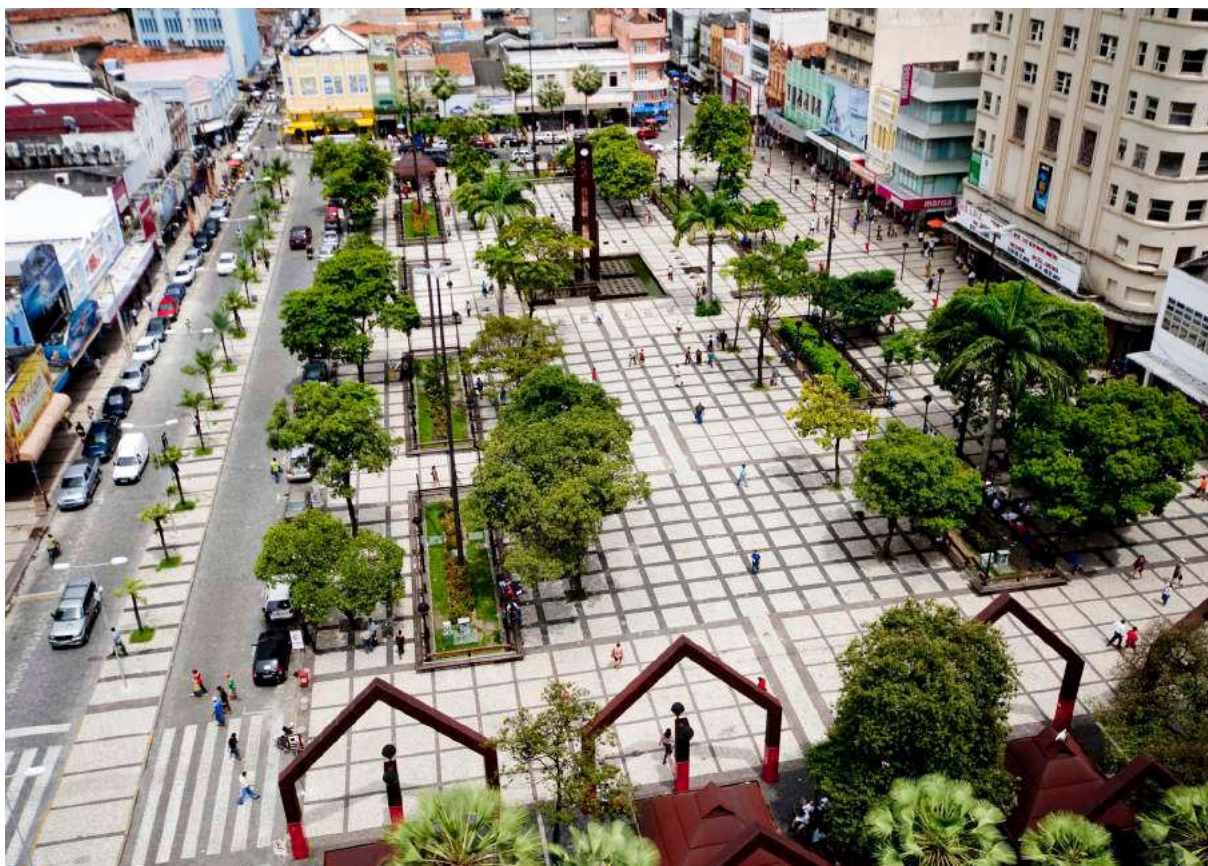
FIGURA 04: Praça do Ferreira após reforma por Fausto Nilo e Delberg Ponce de Leon. Fonte: Google Imagens
