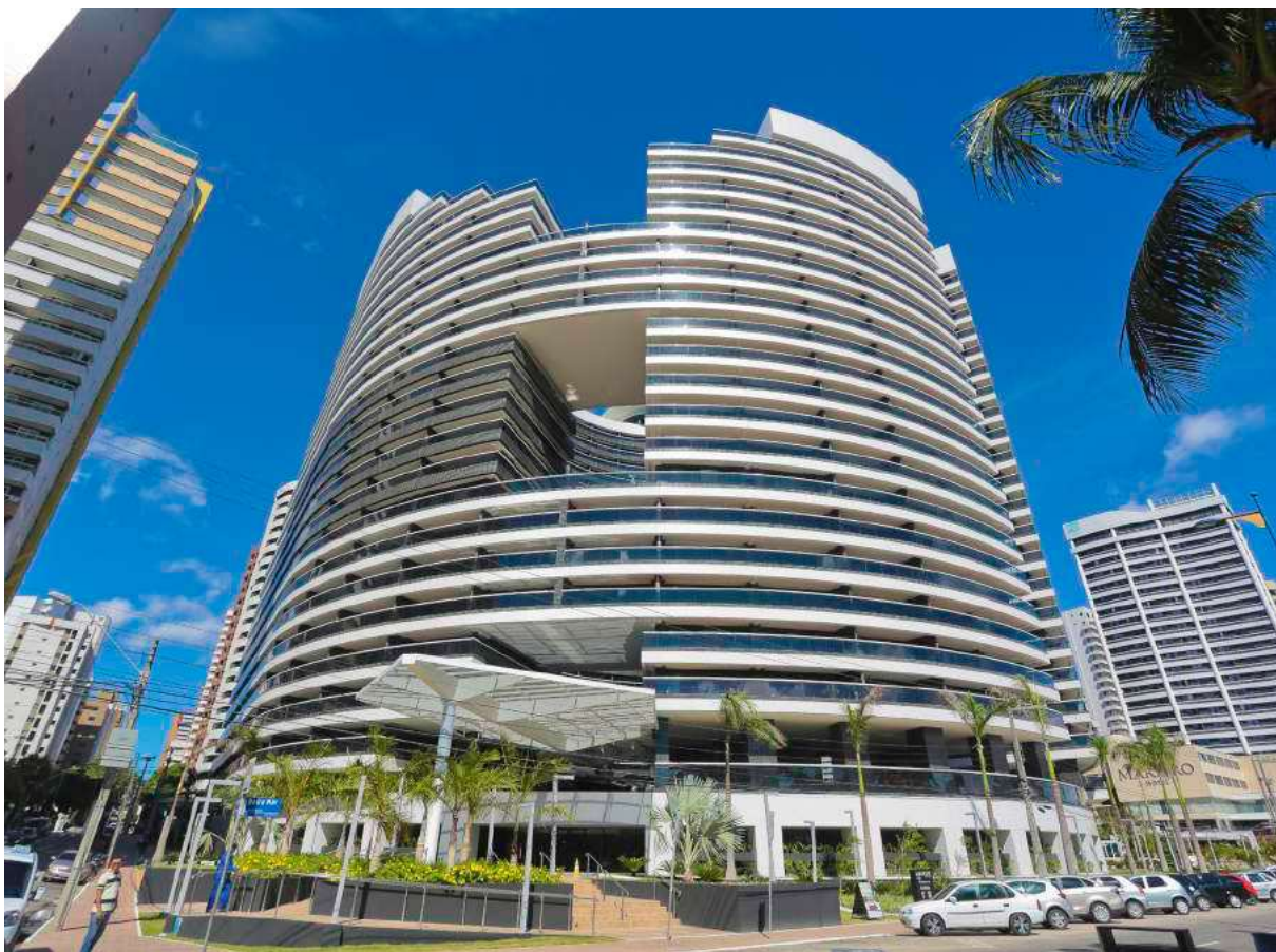
FIGURA 73: Inserção urbana do Landscape. Fonte: Luiz Fiuza Arquitetos Associados..
