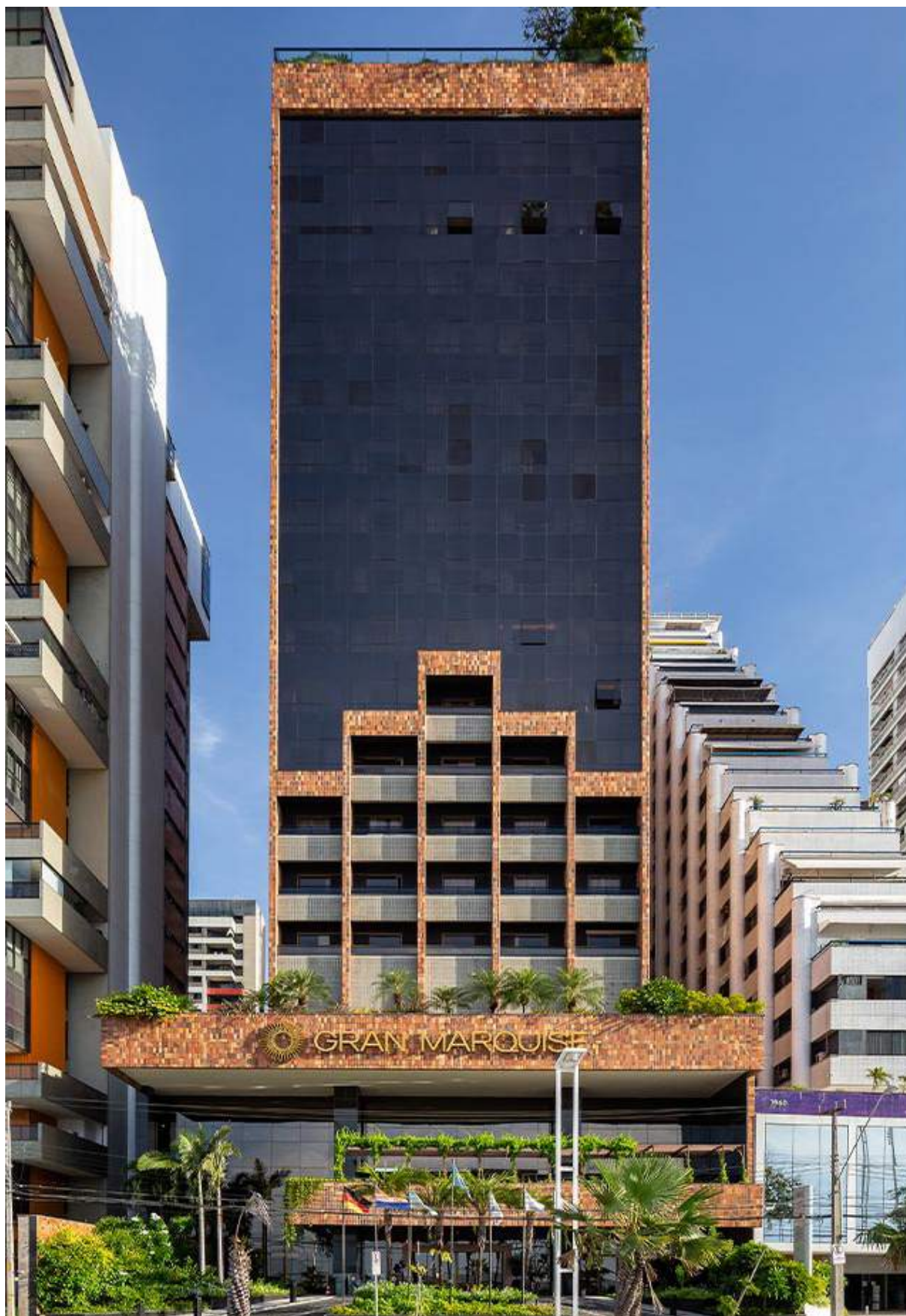
FIGURA 20: Fachada do Hotel Gran Marquise. Foto: Igor Ribeiro.
