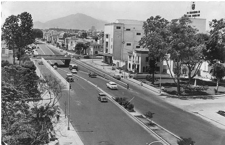
Esquina Av. Arequipa y Av. Javier Prado. Cine Orrantia (Distrito de San Isidro) 140
