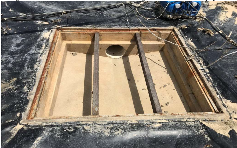
Figura 8 - Dreno central de um viveiro de engorda da Fazenda Expopesca.
