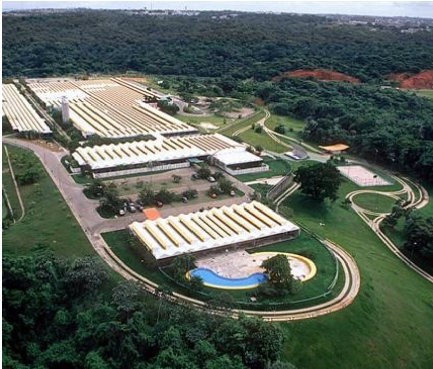
Figura 16 – Vista aérea do Hospital SARAH Salvador.
