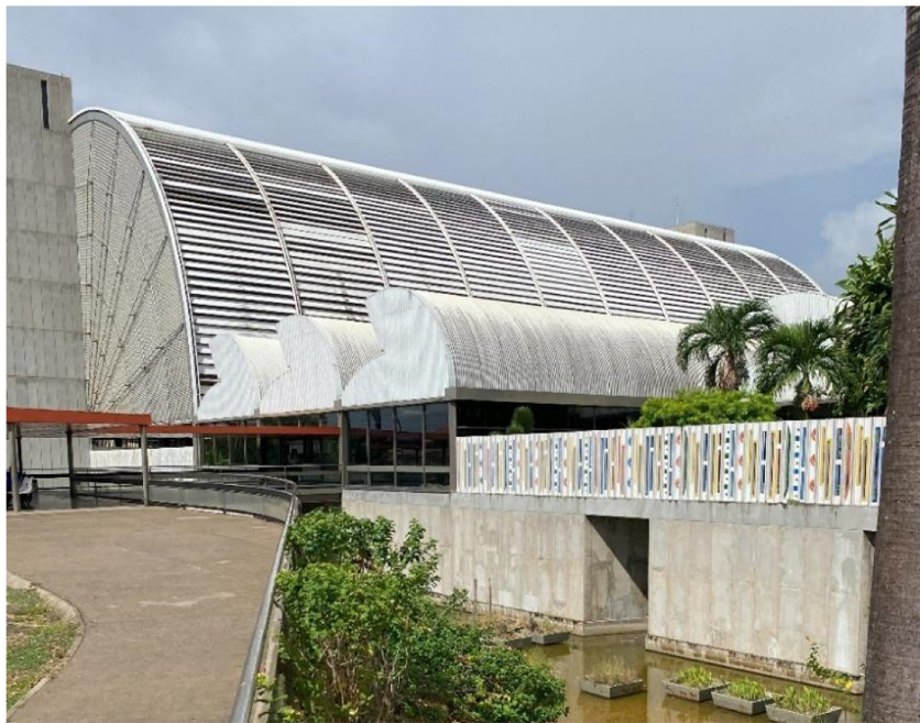
Figura 46 – Acesso principal com ponte sobre lago
