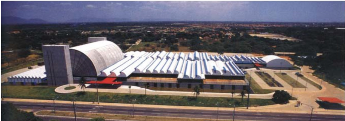
Figura 26 – Vista aérea do Hospital SARAH Fortaleza.
