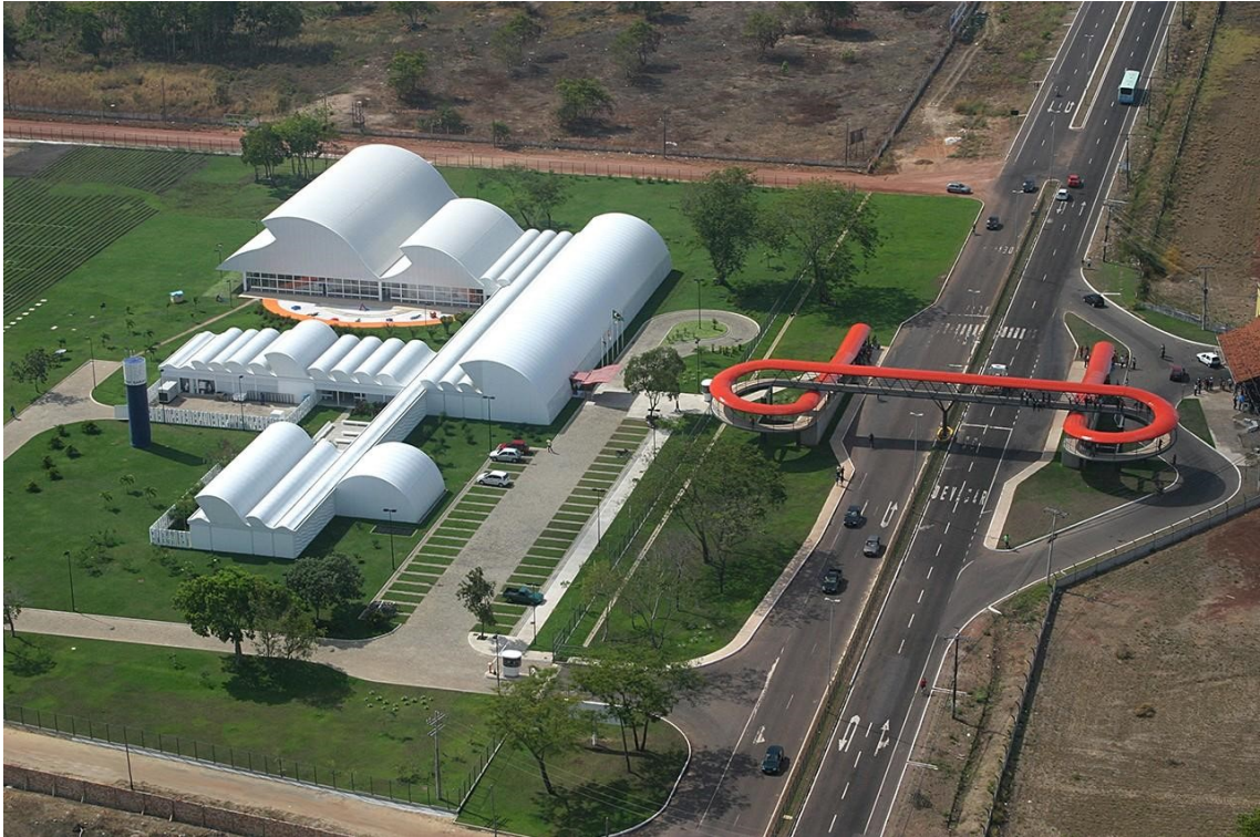
Figura 35 – Vista aérea do Hospital SARAH Macapá.
