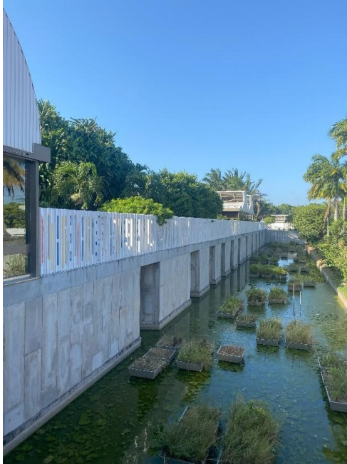
Figura 47 – Fachada com tomadas de ar
