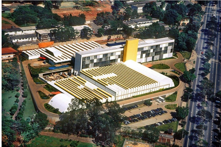
Figura 19 – Vista aérea do Hospital SARAH Belo Horizonte.
