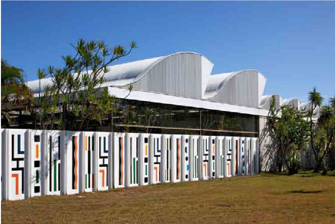
Figura 18 – Vista externa do Hospital SARAH Salvador.
