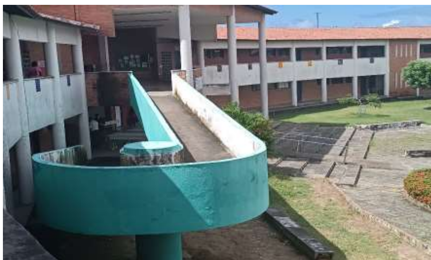
Figura 7 - Rampas centrais da escola.
