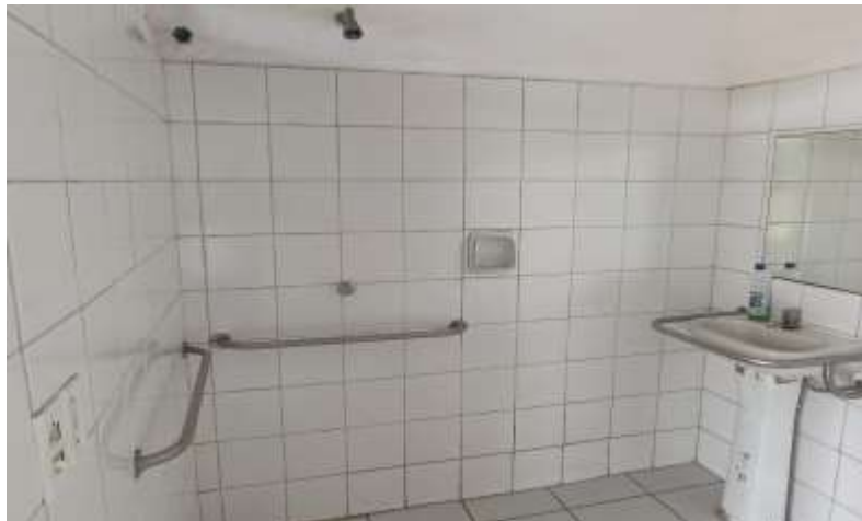
Figura 9 - Banheiro adaptado: pia e chuveiro.
