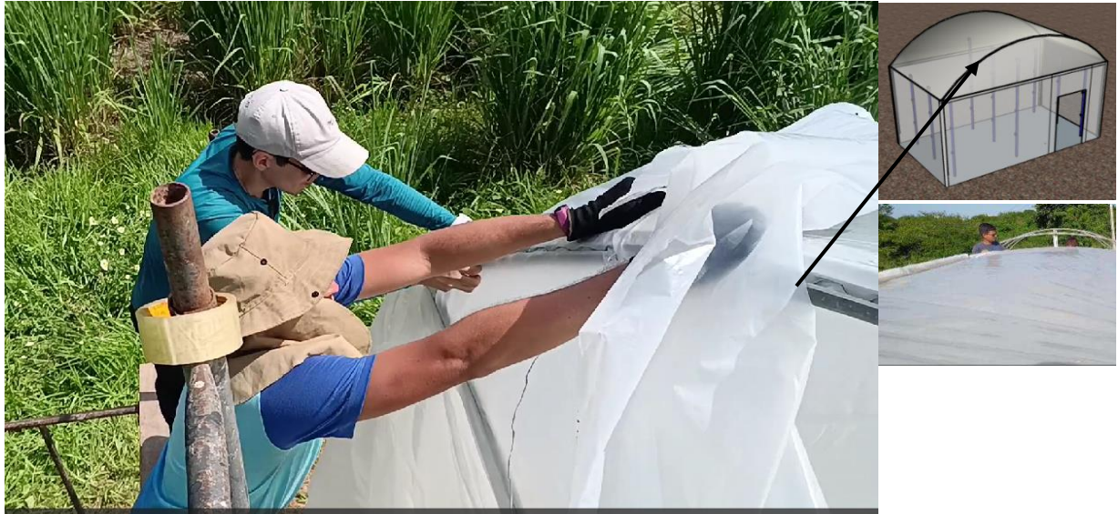
Figura 15: Montagem e fixação das três coberturas nas três estufas.
