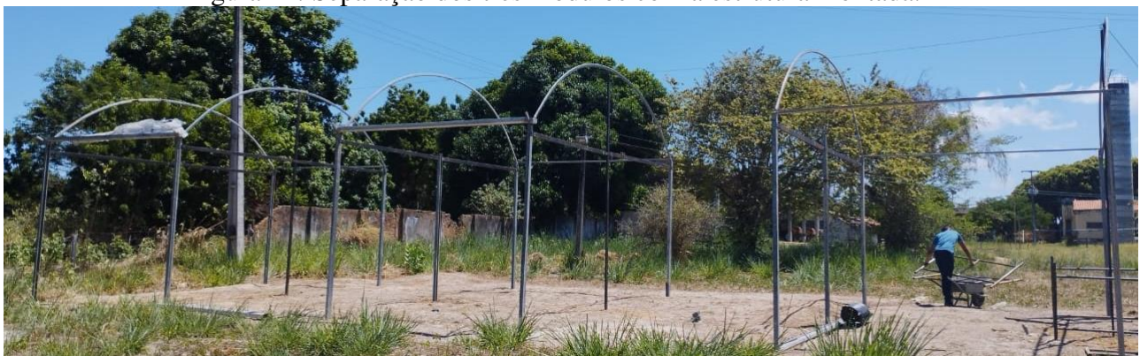
Figura 14: Separação dos três módulos com a estrutura montada.
