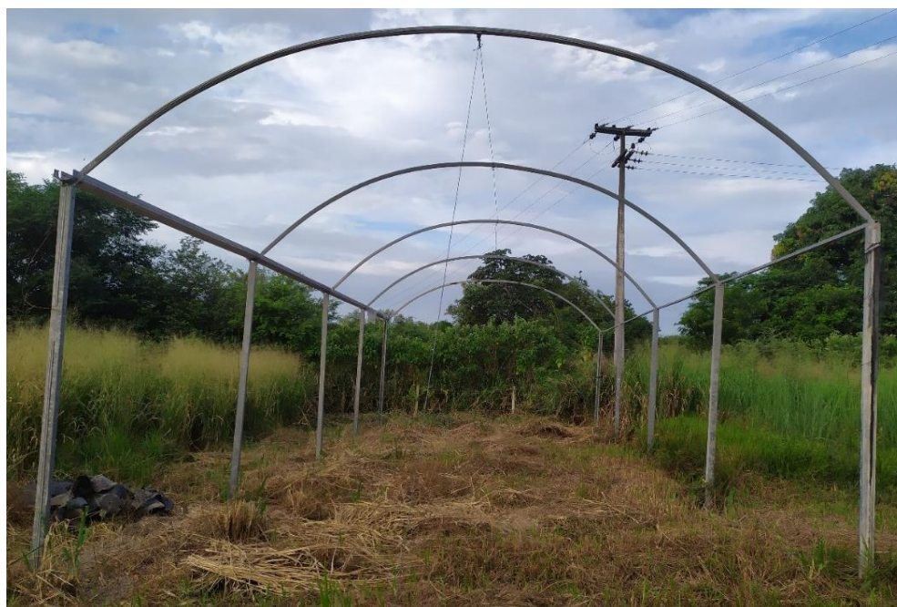
Figura 12: Estufa utilizada como base para a montagem dos módulos independentes
