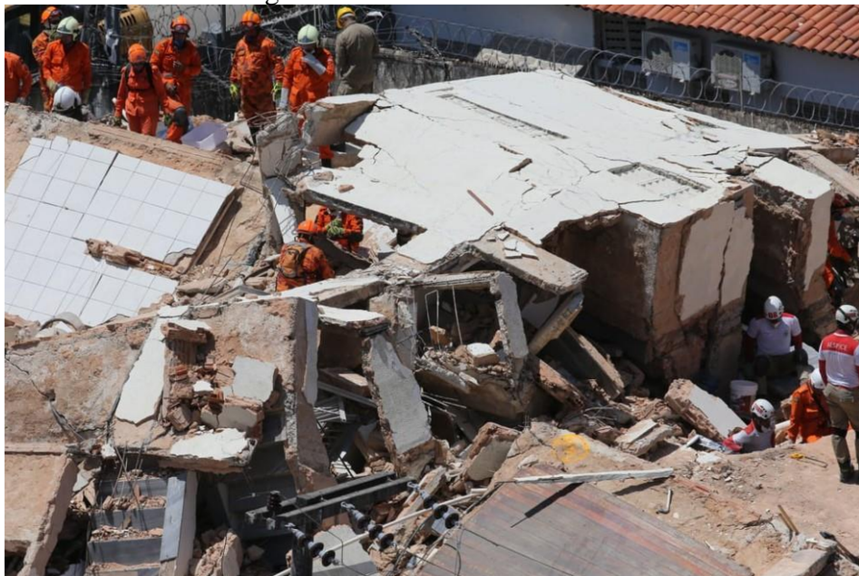
Figura 4 - Escombros Ed. Andrea
