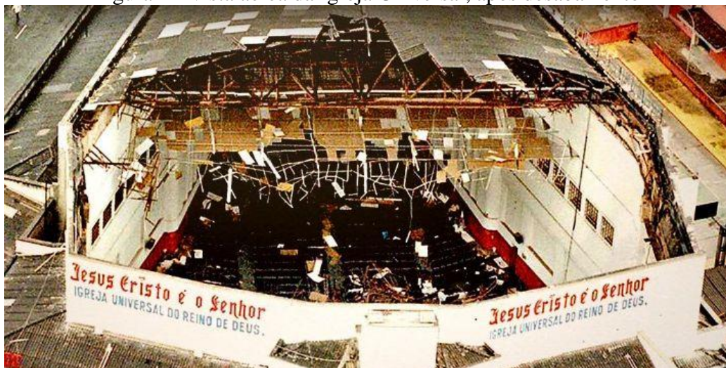
Figura 2 - Vista aérea da Igreja Universal, após desabamento
