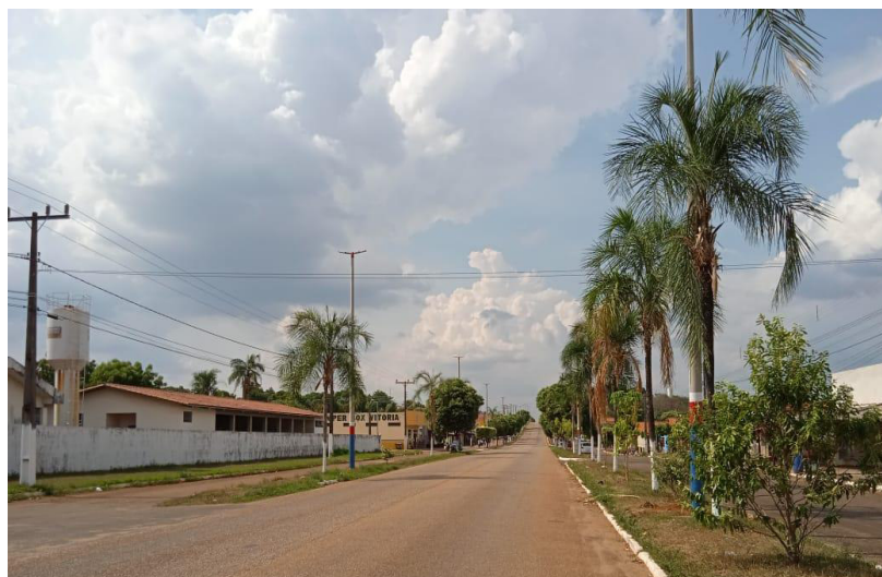
Figura 13 – Trecho da Rodovia TO-162 que passa no município de Carmolândia-TO
