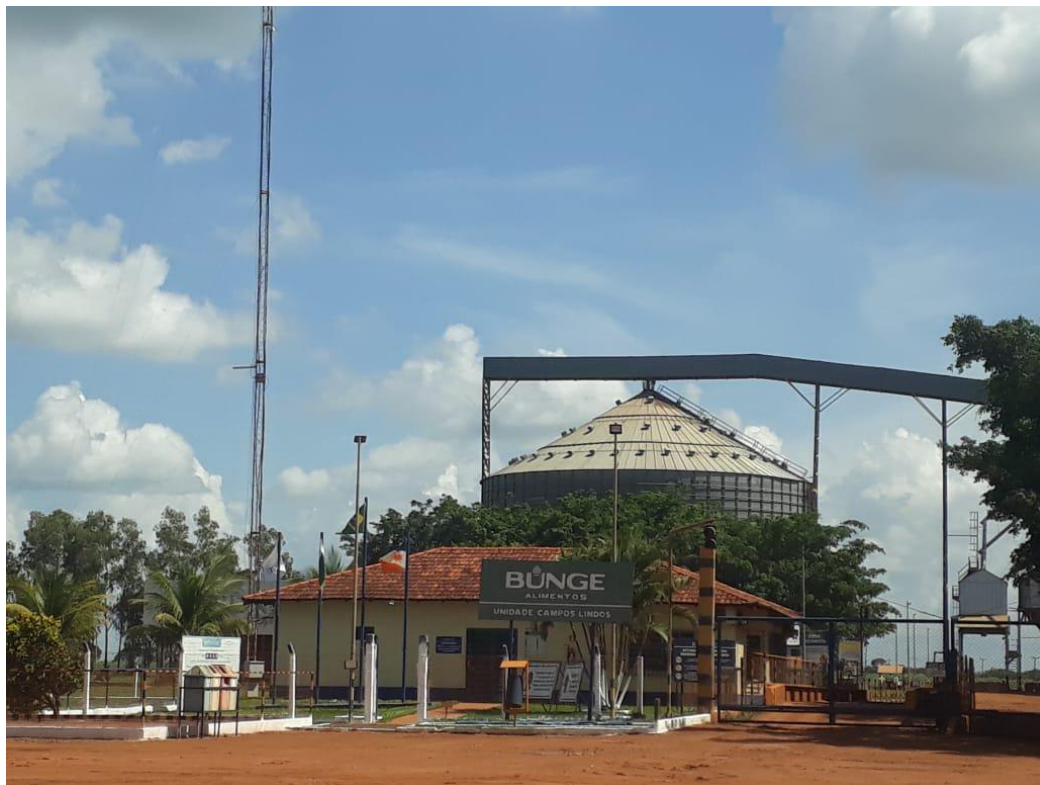
Figura 19 – Silo de armazenamento da Bunge, no município de Campos Lindos-TO
