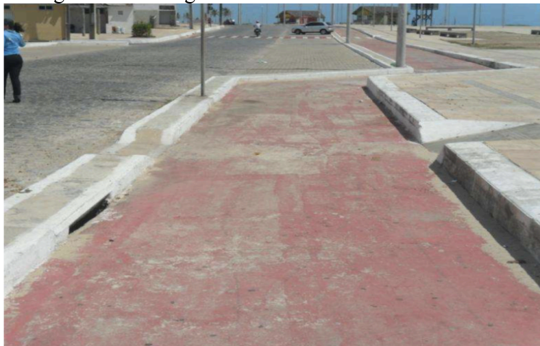
Figura 4 – Drenagem na Orla da cidade de Fortaleza
