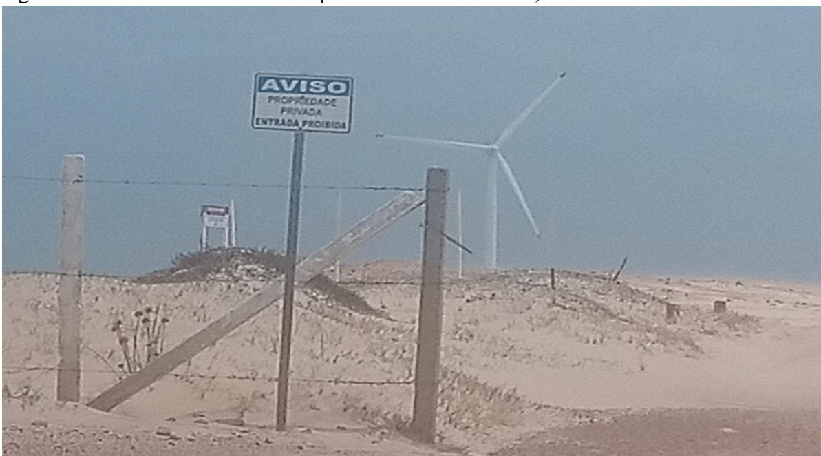
Figuras 6 - Placa na entrada de Complexo Eólico em Aracati, situado em área de dunas
