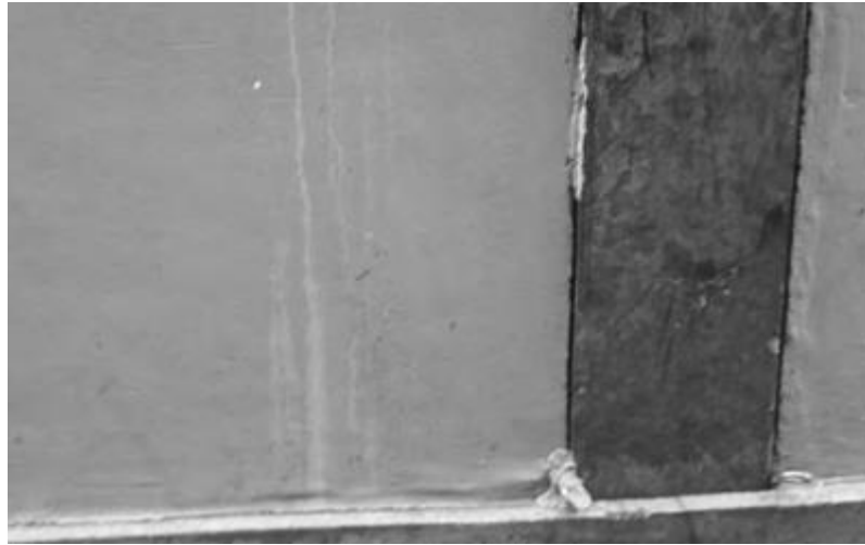
Figura 8 – Eflorescência constituída por um pó branco
