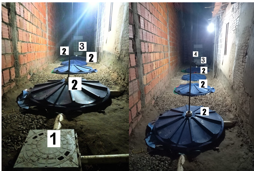
Figura 25 - Sistema composto por caixa de gordura (1) , RAC (2) , Filtro Anaeróbio (3) e Círculo de bananeiras (4).
