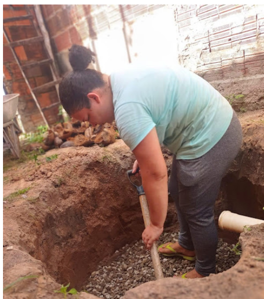
Figura 24 - Início da construção do círculo de bananeiras.
