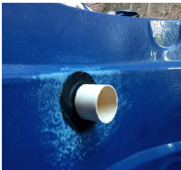
Figura 18 - Vedação das entradas e saídas das tubulações no sistema com câmara de ar de pneus reutilizados.
