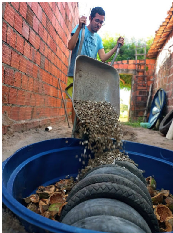
Figura 23 - Filtro Anaeróbio de fluxo ascendente em fase de finalização.
