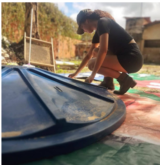
Figura 19 - Reaproveitamento da lona vinílica para vedação superior do sistema.
