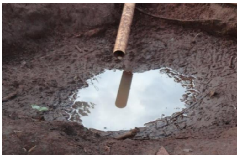
Figura 15 - Condições de saneamento na propriedade.
