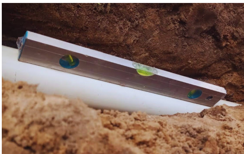
Figura 16 - Ajustando a declividade com nível de alumínio de 3 bolhas.
