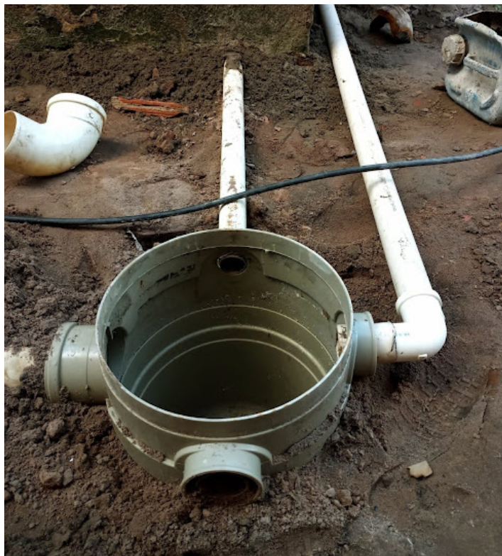
Figura 17 - Instalação das tubulações provenientes da pia da cozinha e banheiro à caixa de gordura.
