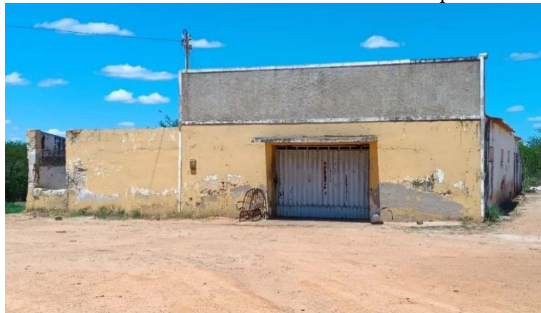
Figura 19 - Sede atual do Abatedouro Público Municipal.
