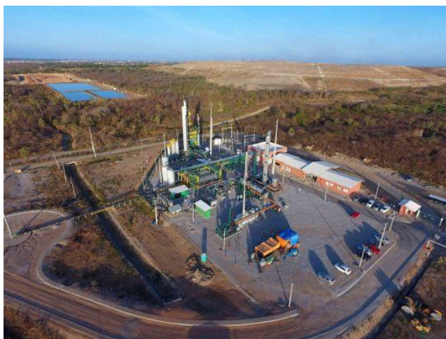
Figura 1: Gás Natural Renovável Fortaleza (GNR).
