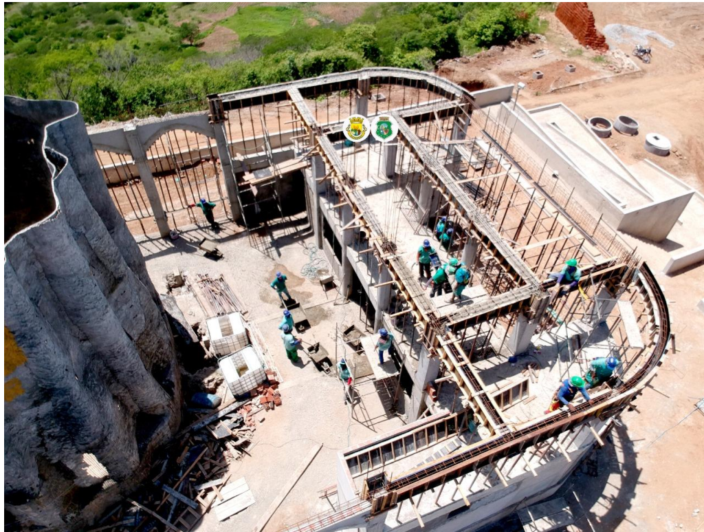
Figura 5: Construção do referido Complexo religioso de Santo Antônio.
