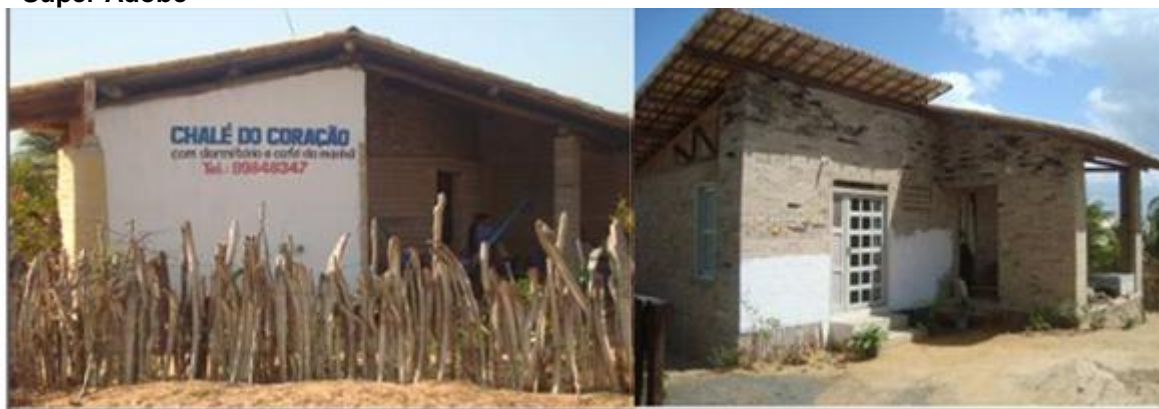
Figura 11 – Chalé do Coração e Chalé do Sol Nascente, Construídos com a Técnica do Super Adobe
