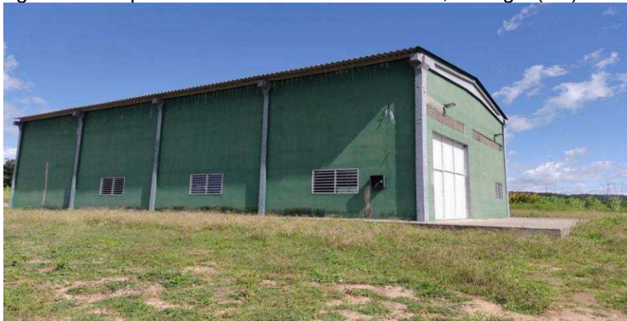
Figura 2 – Galpão do Assentamento Queimadas, Remígio (PB)
