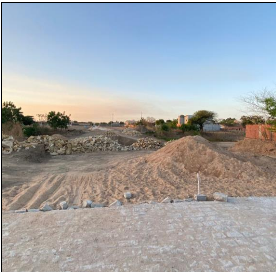
Figura 9a – Areia de construção
