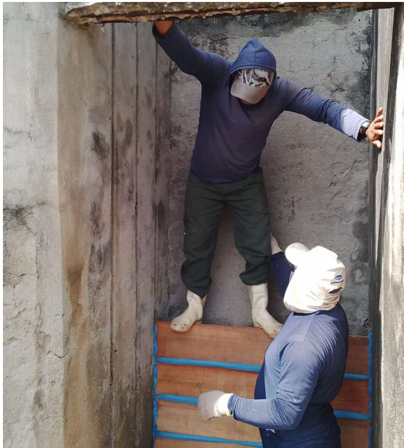
Figura 7 - Comporta sendo vedada utilizando tábuas e esponjas.
