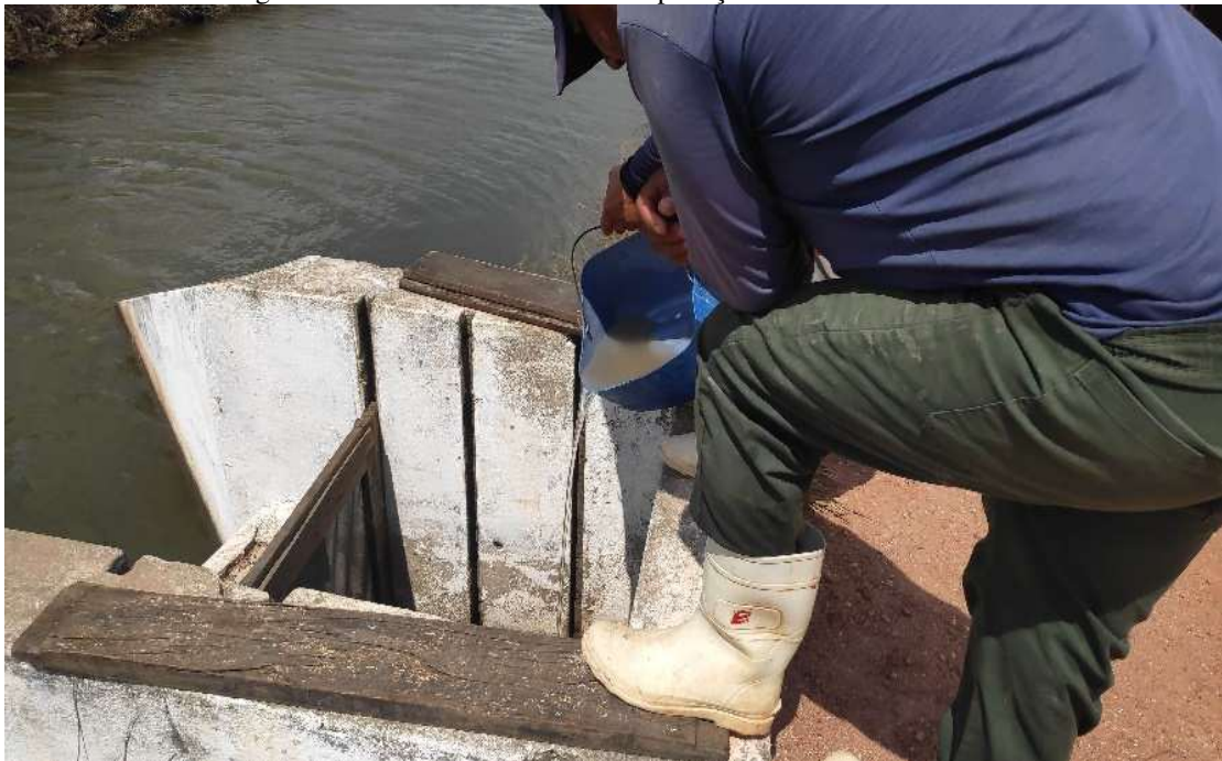
Figura 11 - Colaborador fazendo a aplicação do silicato de sódio.
