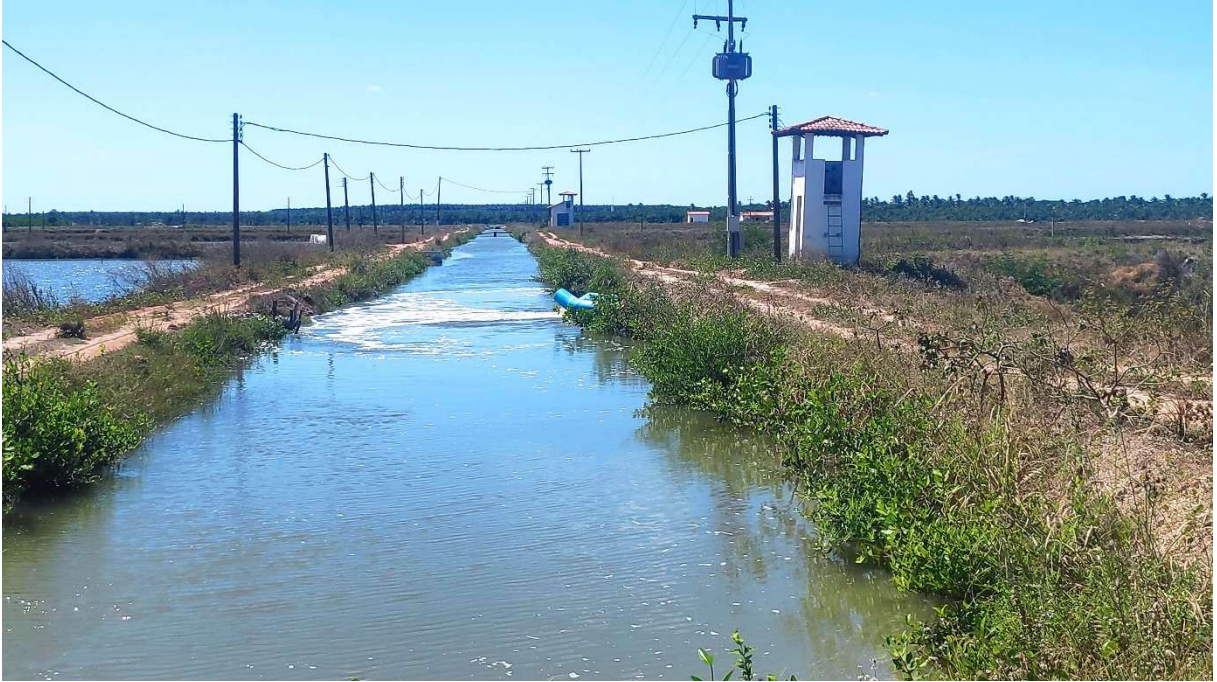
Figura 3 - Canal de abastecimento dos viveiros.
