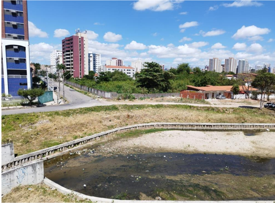
Figura 9 - Obras do trecho sentido Papicu.
