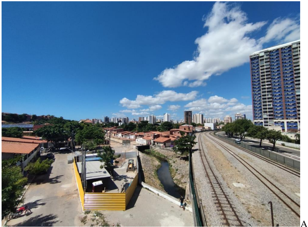
Figura 10 - Trecho das obras cruzando os trilhos do VLT e trem, indo no sentido do Bairro Papicu. A: vista Panorâmica. B: vista mais próxima do Riacho Papicu.
