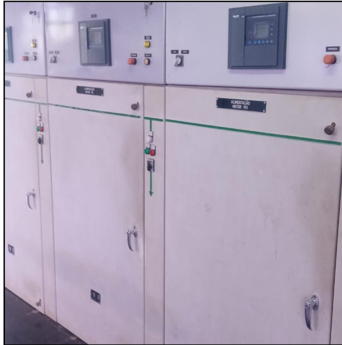
Figura 40 – CCMs dos motores 2 e 3
