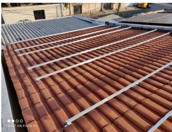
Figura 7 – Instalação de trilhos em telhado colonial
