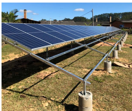
Figura 8 – Instalação de estruturas em solo
