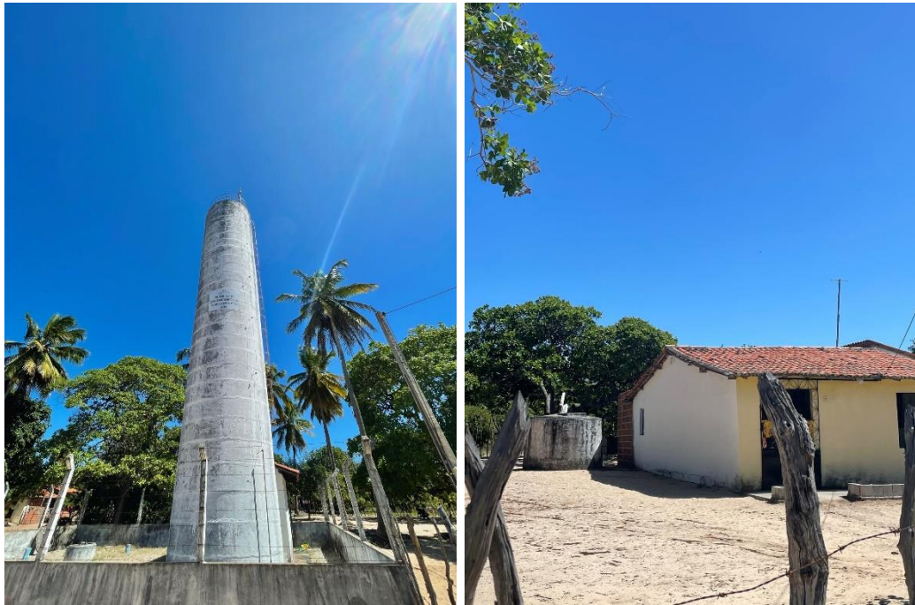
Figura 03: Torre de abastecimento de água e cisterna no quintal de uma casa.
