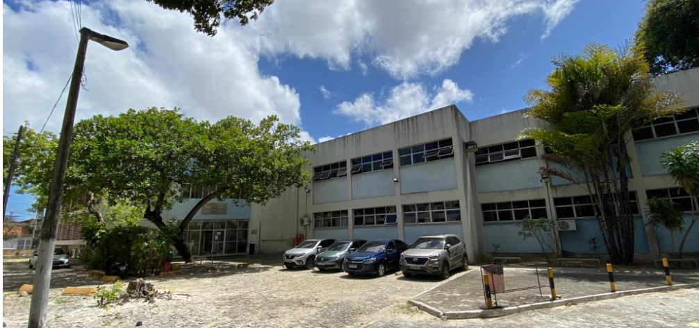
Figura 4 -Fachada do Bloco 125
