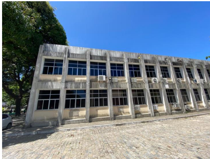
Figura 10- Vista Lateral do Bloco
