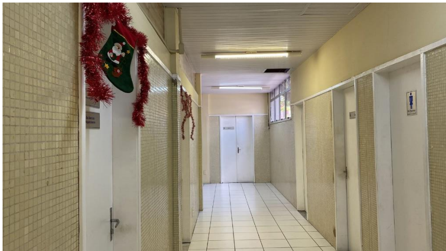
Figura 5- Corredor Pavimento Térreo
