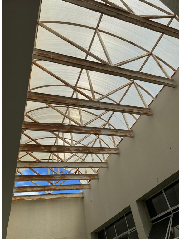
Figura 11 - Coberta da edificação
