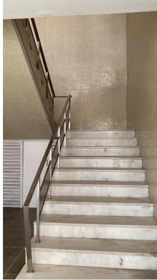
Figura 9 - Escada de Acesso ao Pavimento Superior
