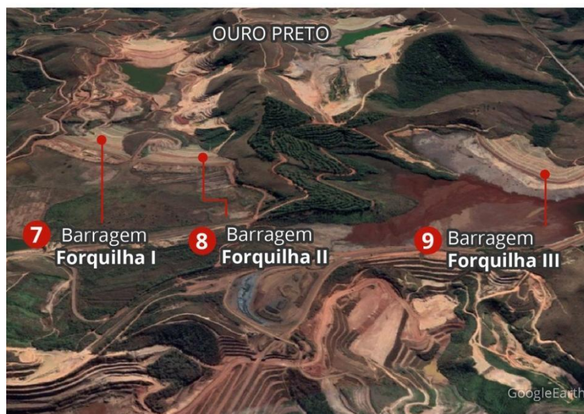
Figura 15 - Complexo de barragens (Mina Fábrica)
