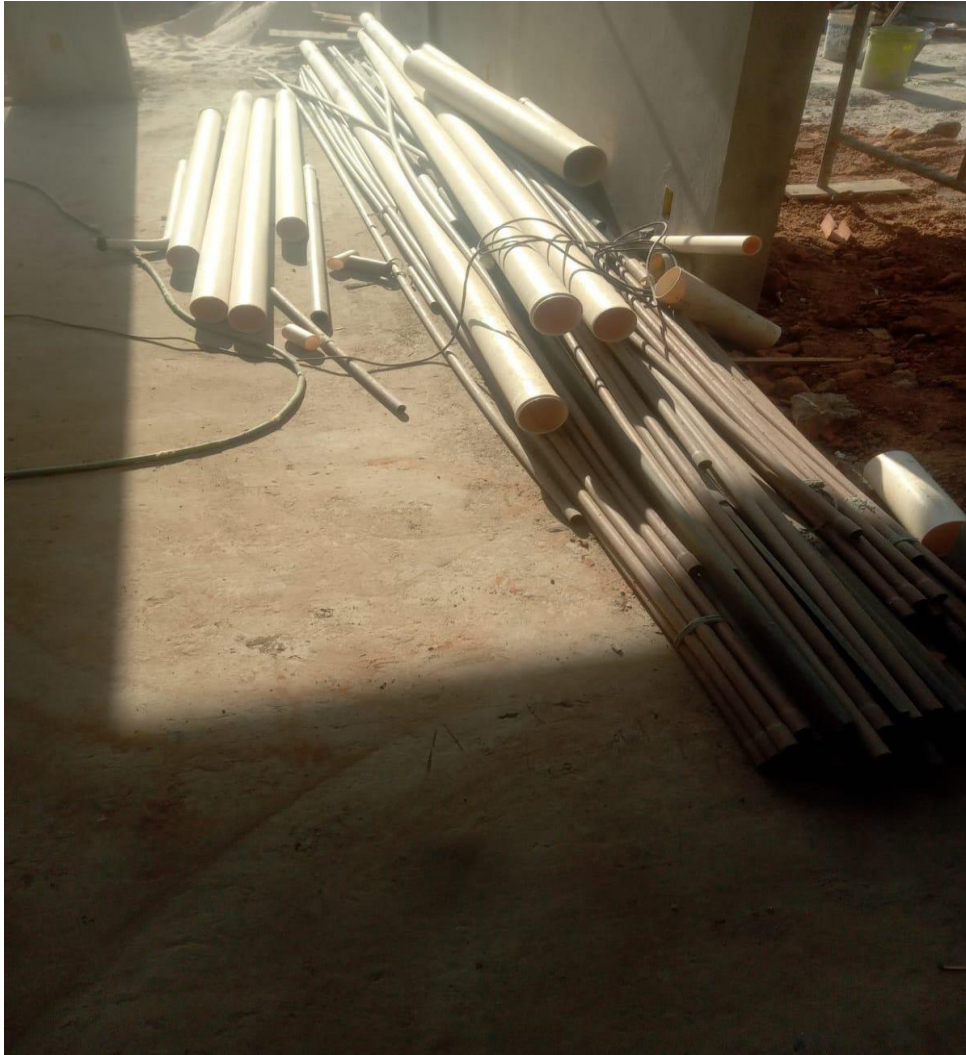
Figura 6- Materiais da obra C armazenados de forma aleatória.
