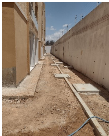
(d) Acabamento das caixas de inspeção e passagem do esgoto
