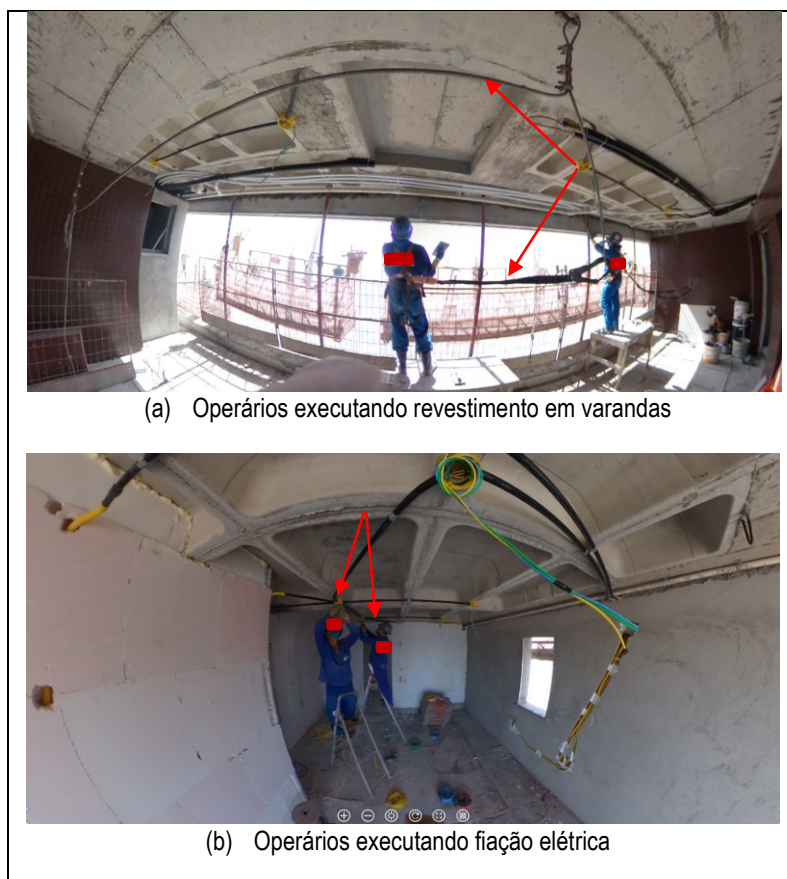
Figura 30 - Exemplos de verificação da segurança com a Câmera 360 graus
