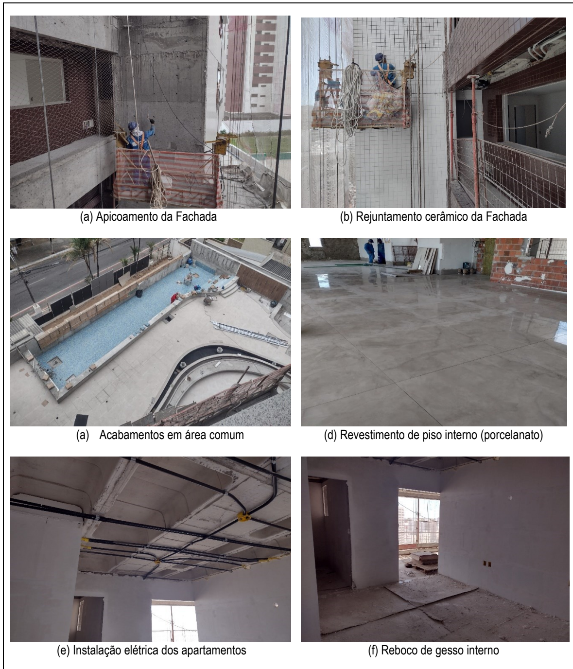
Figura 15 – Exemplos de serviços em execução na obra da Empresa Alfa
