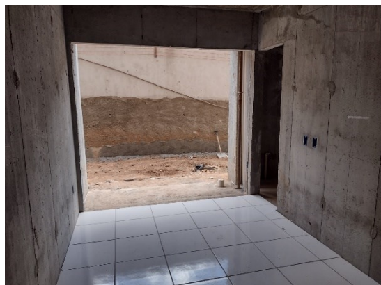
(b) Revestimento cerâmico (piso interno)
