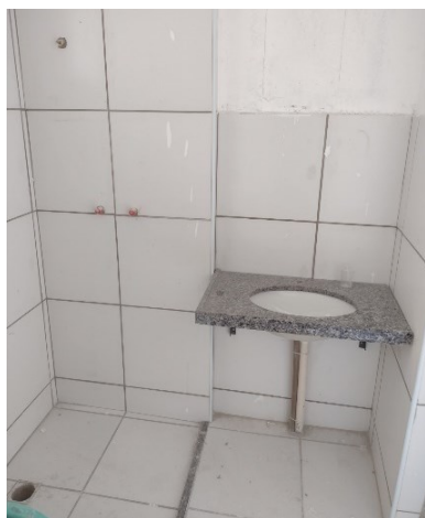
(c) Revestimento cerâmico (piso e parede) e bancadas dos WC's
