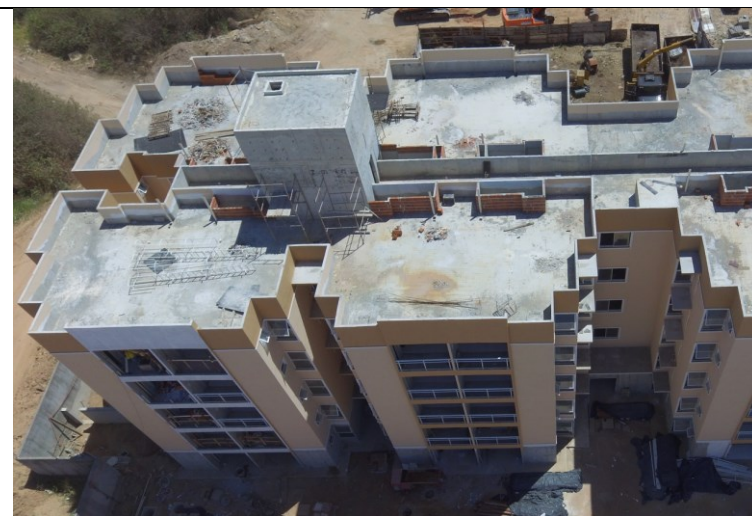
(a) Serviços da Coberta em 02.09.21
