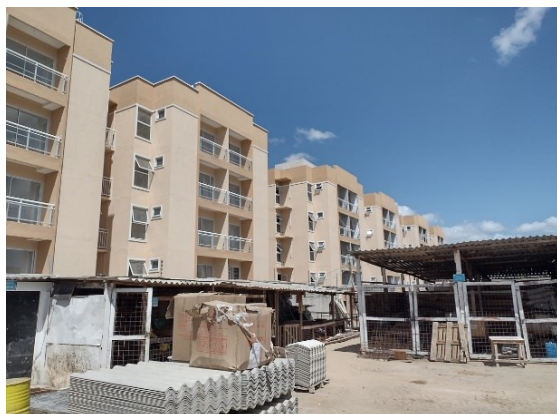
(a) Instalações do canteiro (estoques)
