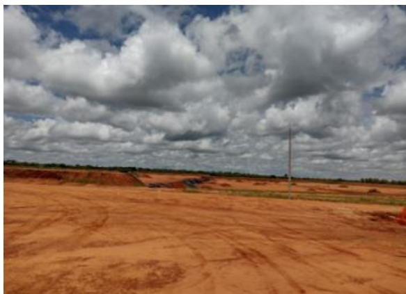
Figura 5: Execução da camada de base do Aterro.
