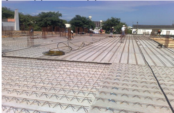
Figura 12- Laje pré-fabricada do tipo painel.
