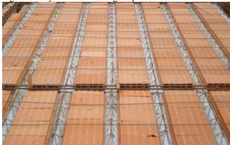
Figura 13 - Laje nervurada com vigotas pré-fabricadas.
