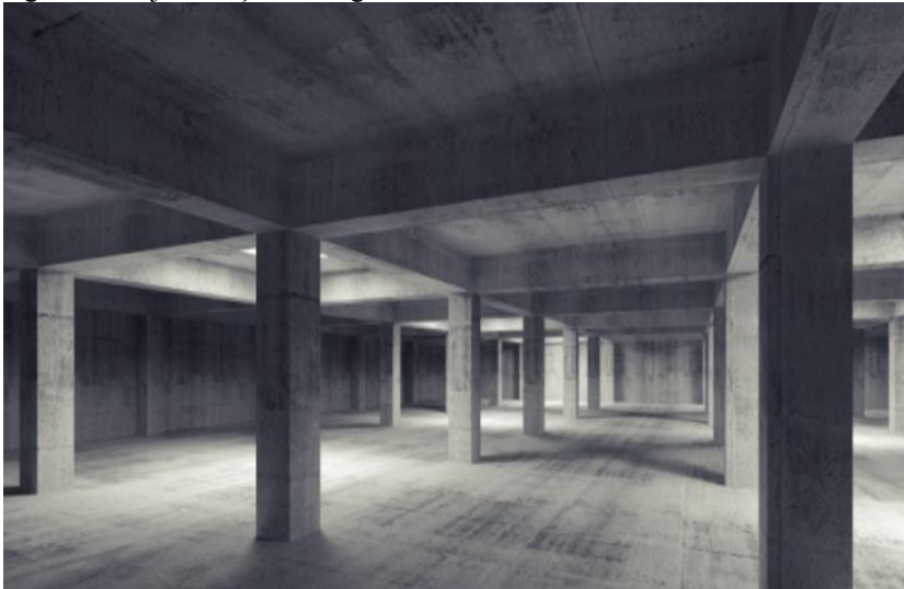
Figura 9 - Laje maciça com vigas.
