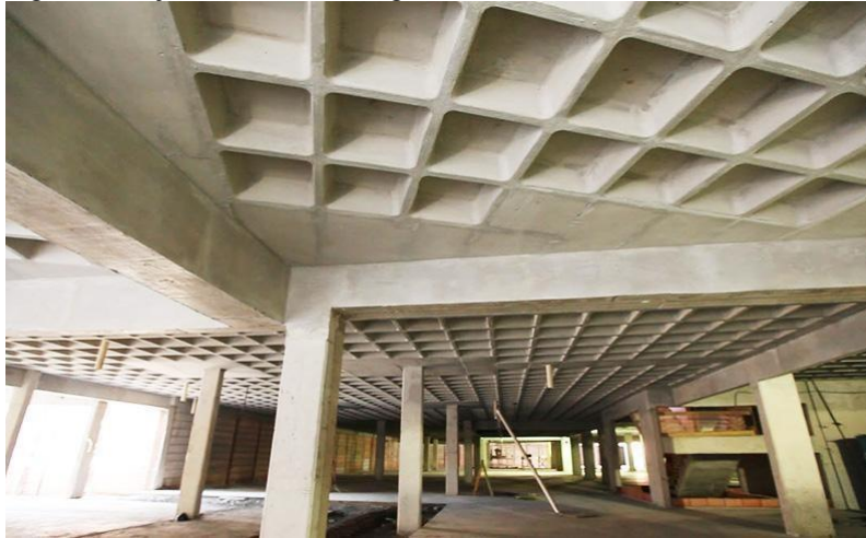
Figura 8 - Laje nervurada com vigas.
