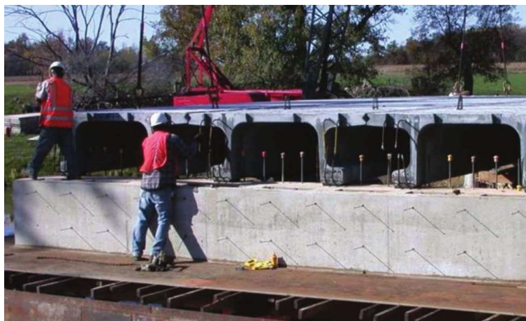
Figura 3 – Pontes com seção PI utilizando UHPC com fibras de aço
