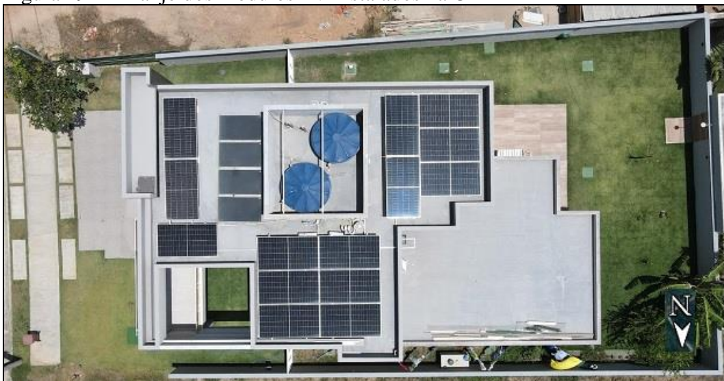
Figura 19 – Arranjo dos módulos FV instalados na UF
