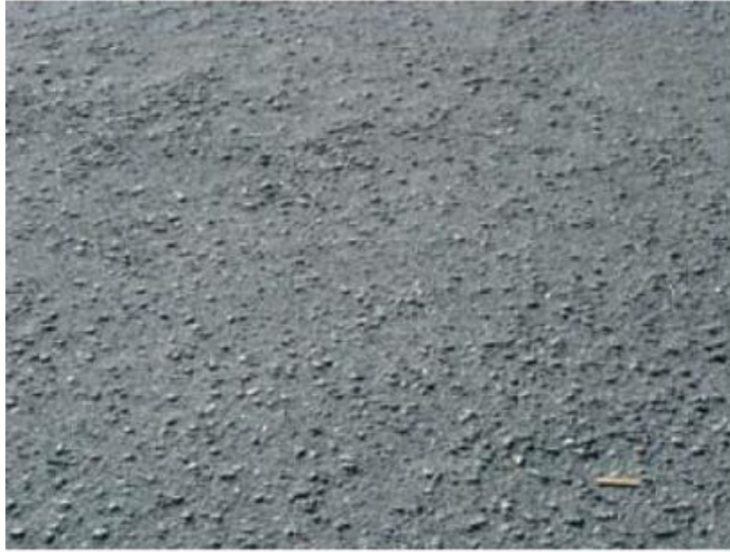
Figura 13 - Exemplo de desgaste
