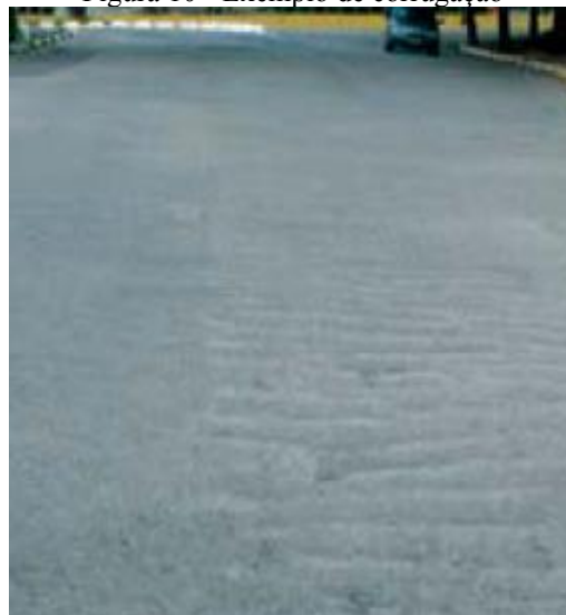
Figura 10 - Exemplo de corrugação
