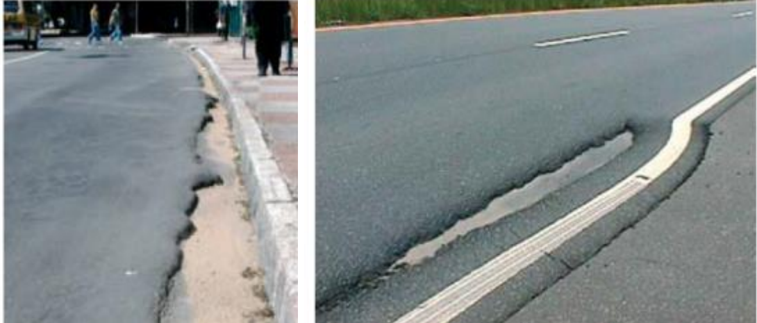
Figura 11 - Exemplos de escorregamento
