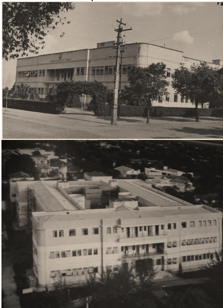
Figura 52: HGV com dois pavimentos (década de 1940) e depois da reforma com três pavimentos.
