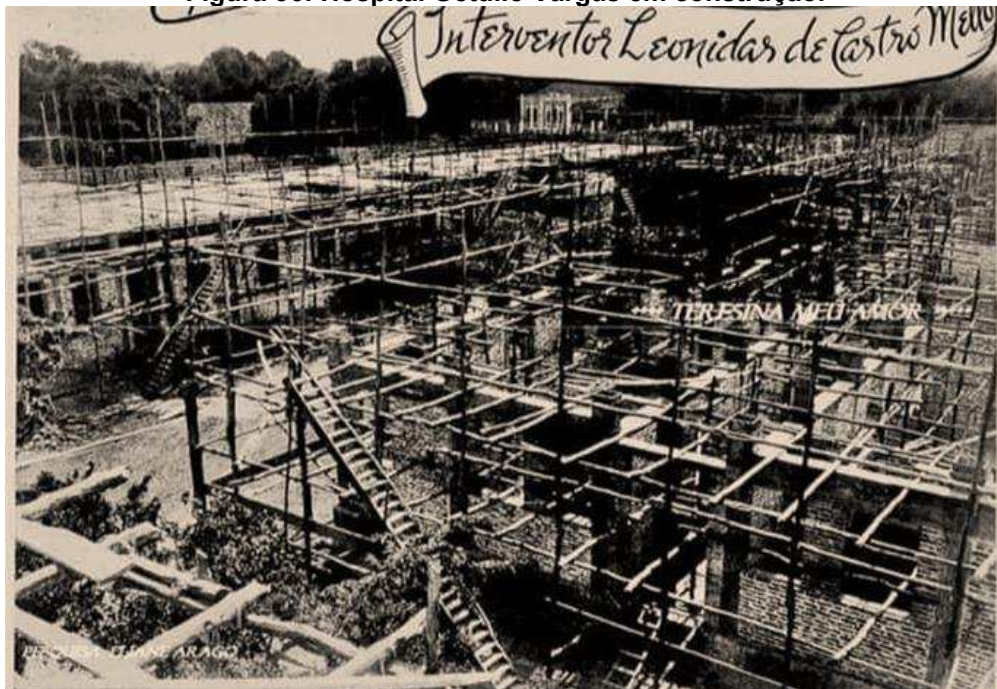
Figura 56: Hospital Getúlio Vargas em construção.
