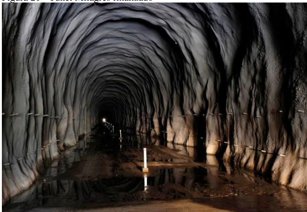
Figura 21 - Túnel Milagres finalizado
