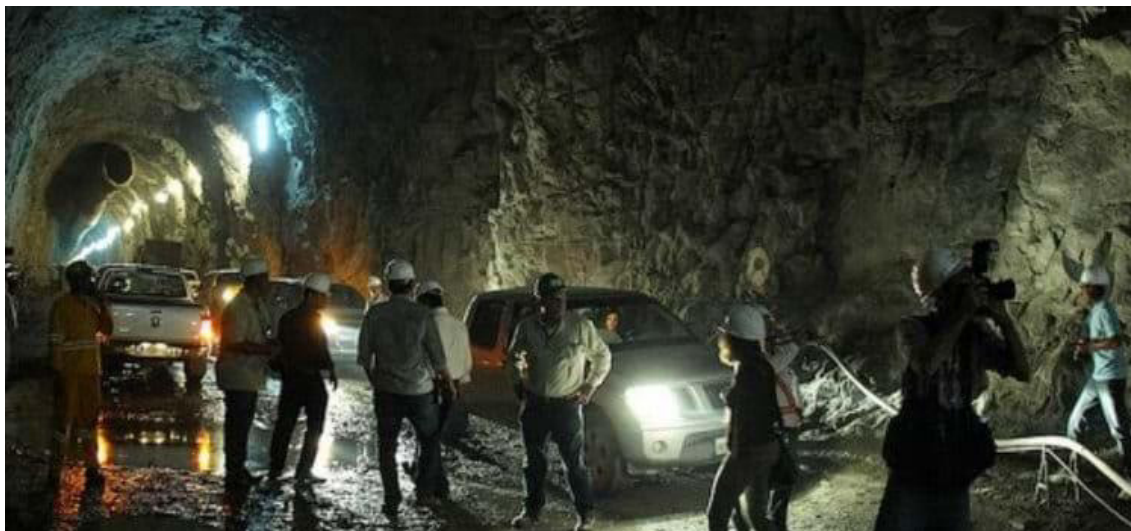
Figura 6 – Obras do Túnel Cuncas I
