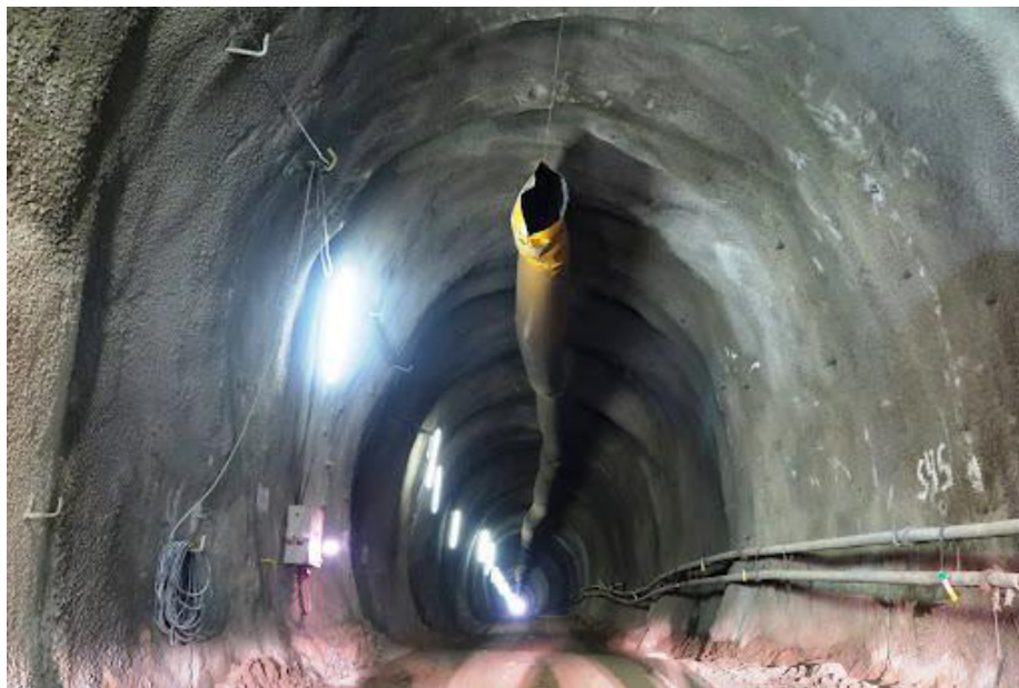
Figura 25 - Interior do Túnel Veneza
