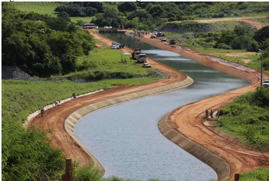
Figura 2 - Canal do Cinturão das Águas do Ceará.
