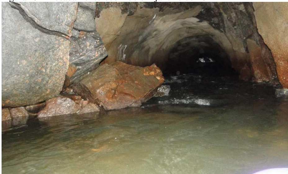
Figura 29 - Desabamento ocorrido em janeiro de 2021
