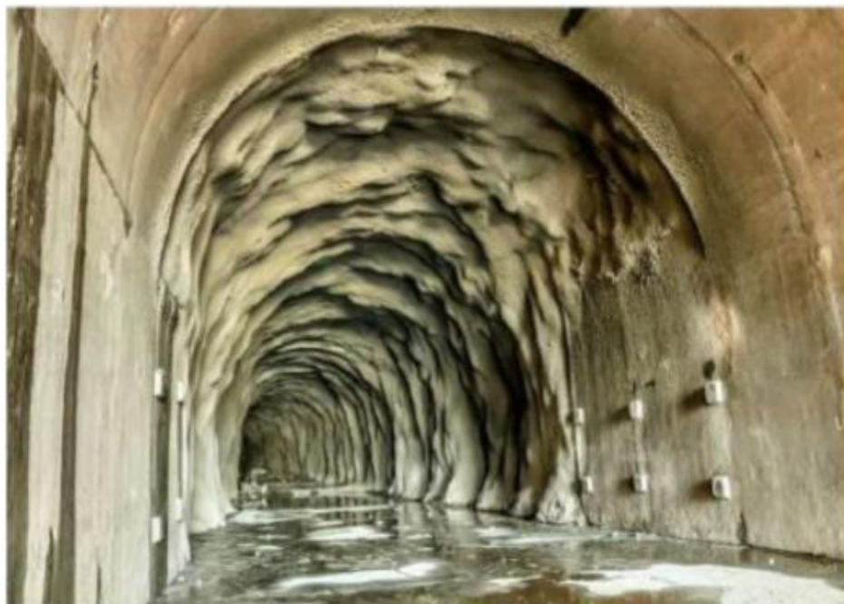
Figura 28 - Aspecto final do tratamento no túnel da UHE Mauá
