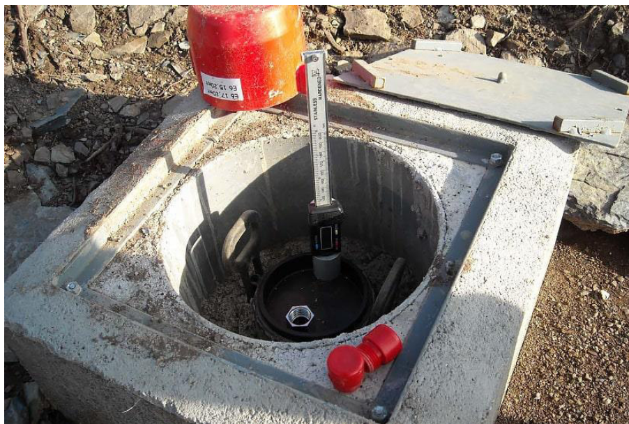
Figura 10 - Extensômetro do Túnel do Mato Forte, Portugal
