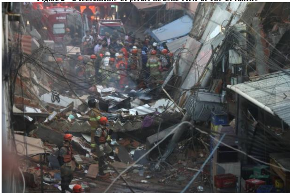
Figura 2 - Desabamento de prédio na zona oeste do Rio de Janeiro
