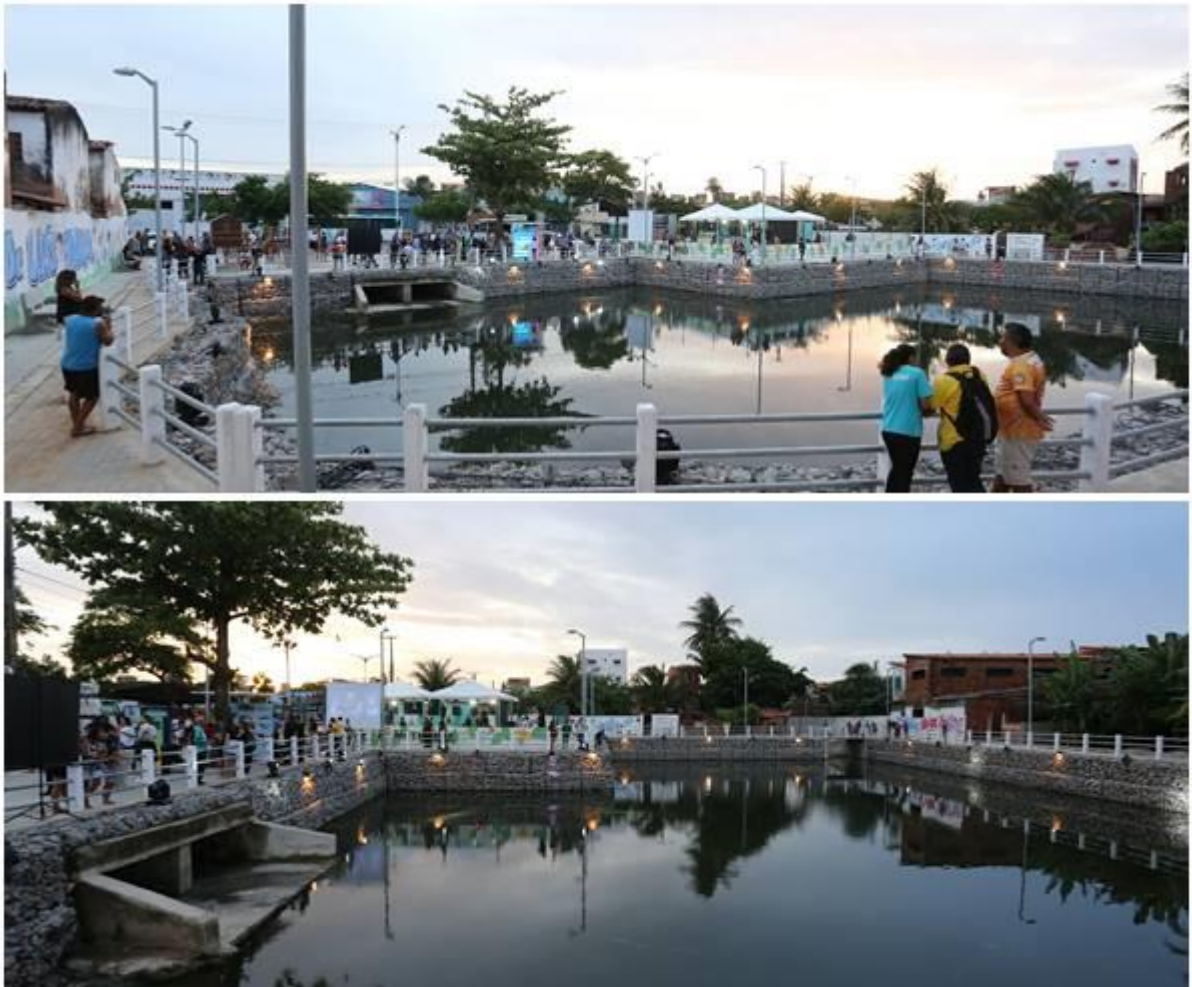
Figura 09 – Estrutura interna constituinte da Lagoa do Mel, representada pelo Muro de Gabião
