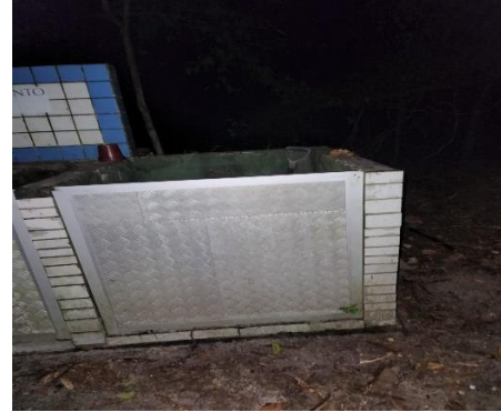
Figura 7 - Compostagem de pequena escala em estrutura de alvenaria
