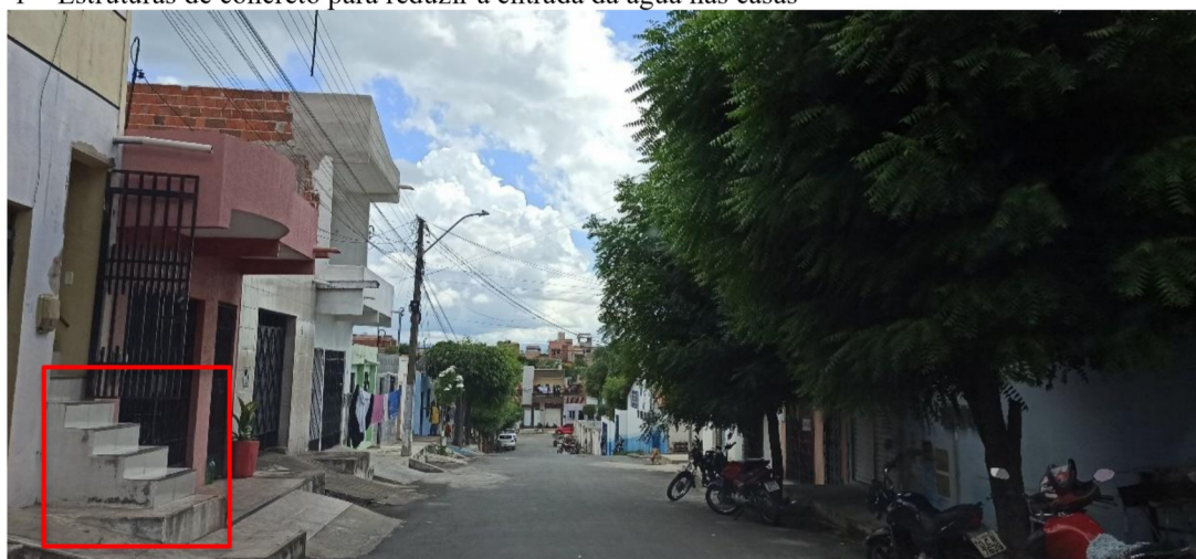
2 – Entrada da casa elevada com muitos degraus para evitar as inundações
