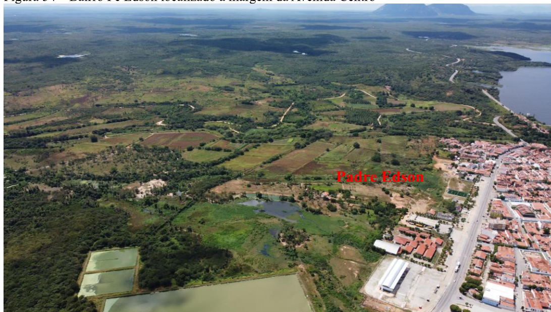
Figura 34 – Bairro Pe Edson localizado a margem da Avenida Centro
