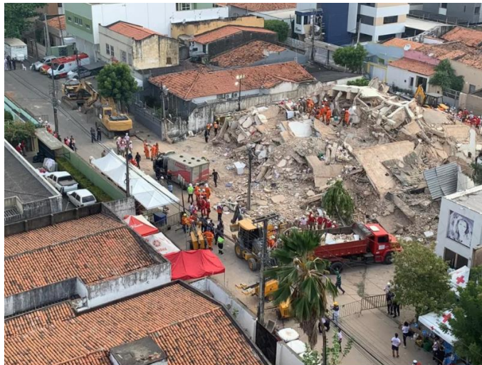
Figura 4 – Escombros do desabamento do Edifício Andrea situado em Fortaleza.
