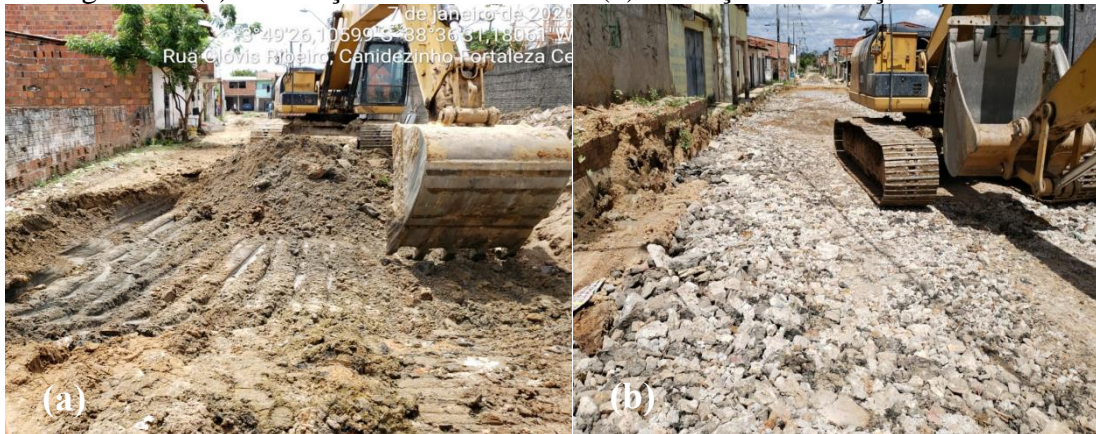
Figura 8 – (a) Escavação de solo natural e (b) execução de reforço do subleito
