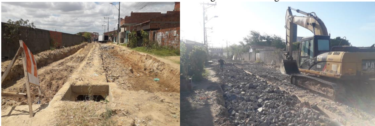
Figura 10 – (a) Escavação em solo natural e (b) execução de reforço do subleito com presença de interferência subterrânea de galeria de drenagem
