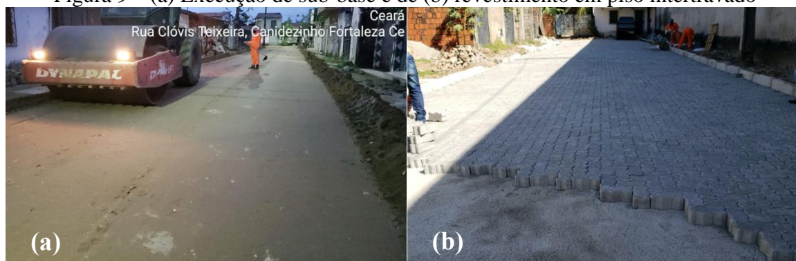
Figura 9 – (a) Execução de sub-base e de (b) revestimento em piso intertravado
